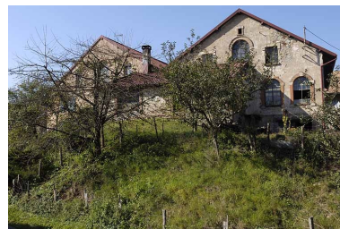
Pignons est de l'atelier de fabrication. Phot. Jérôme Mongreville IVR43_20057000496NUCA
