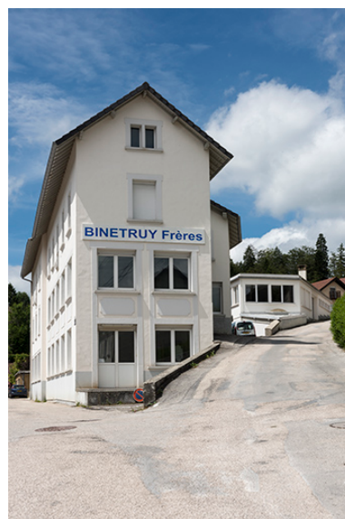
Bâtiments rue de l'Horlogerie : façade latérale est. Phot. Sonia Dourlot IVR43_20162500798NUC4A
