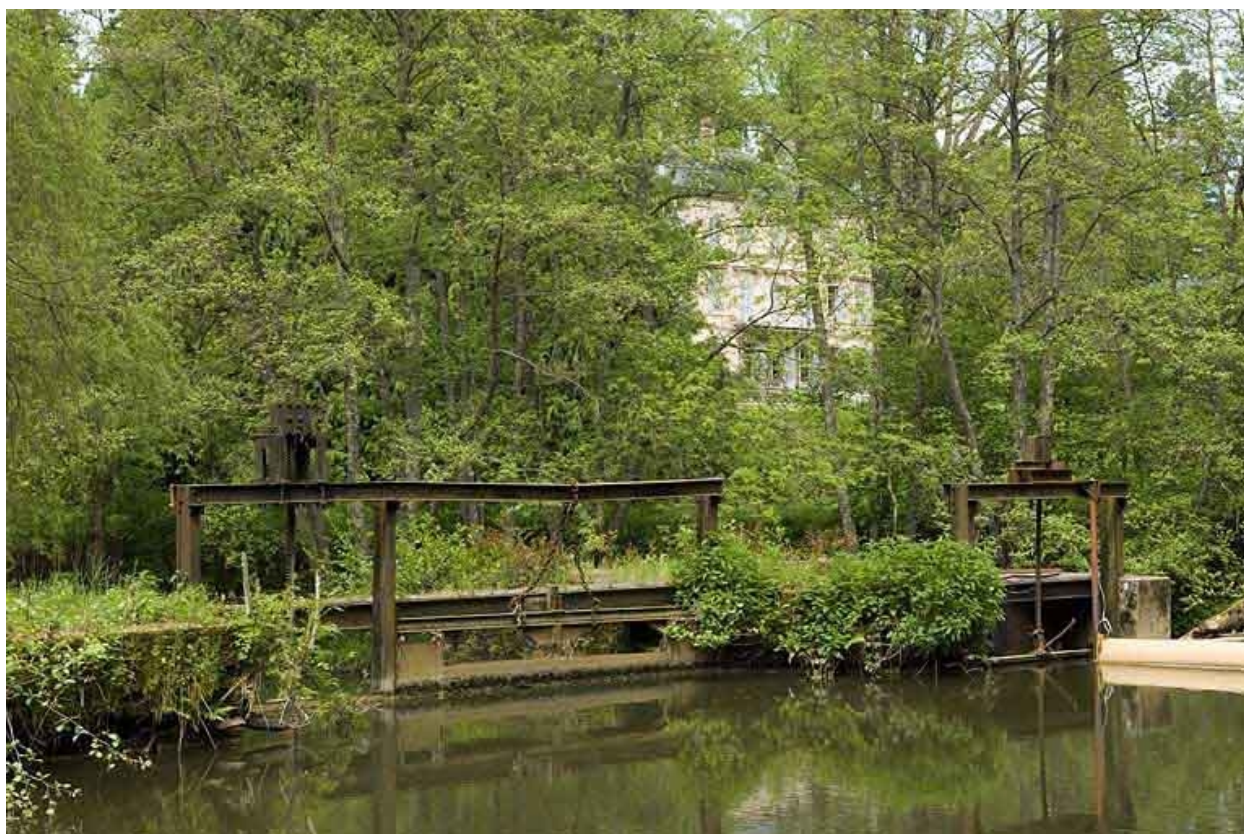
Vannage sur le bief d'amenée.
