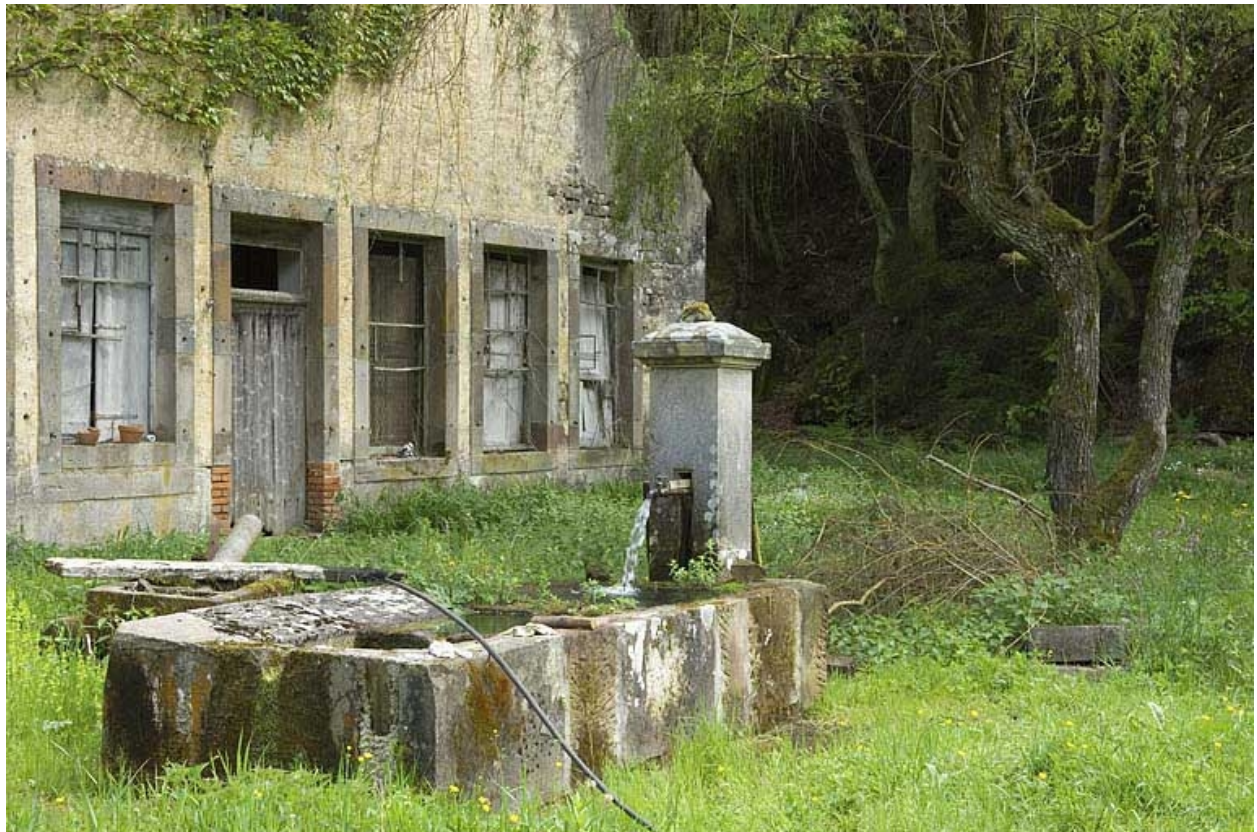
Façades antérieures depuis l'ouest.
