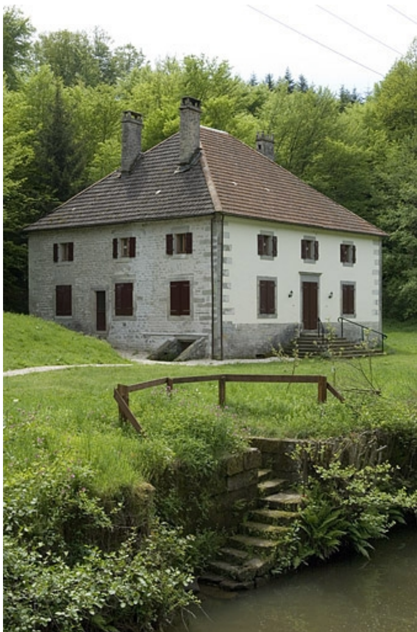
Logement patronal (1817) vu de trois quarts.
