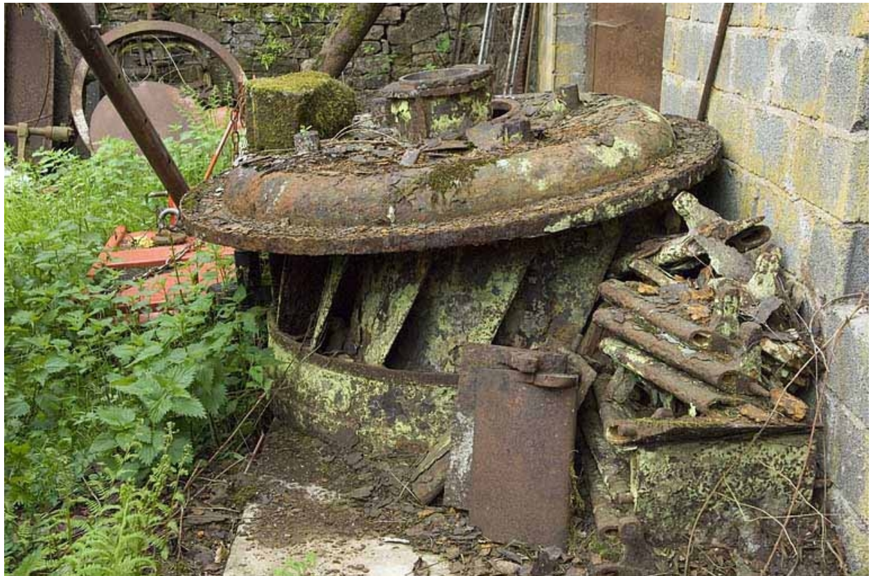
Vestiges d'une turbine Francis.
