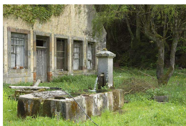
Façades antérieures depuis l'ouest.
