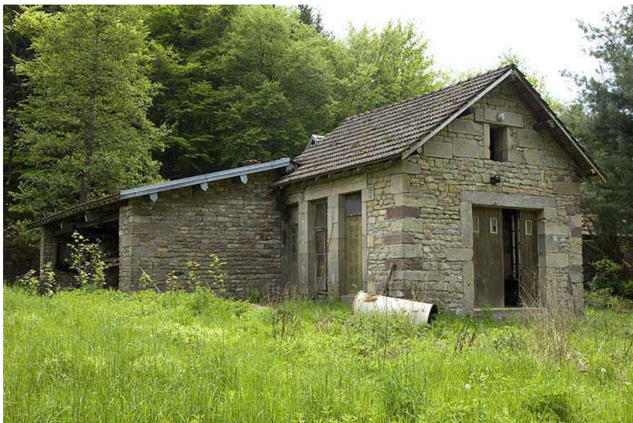
Bâtiment d'eau (local des turbines).
