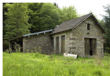
Bâtiment d'eau (local des turbines).
