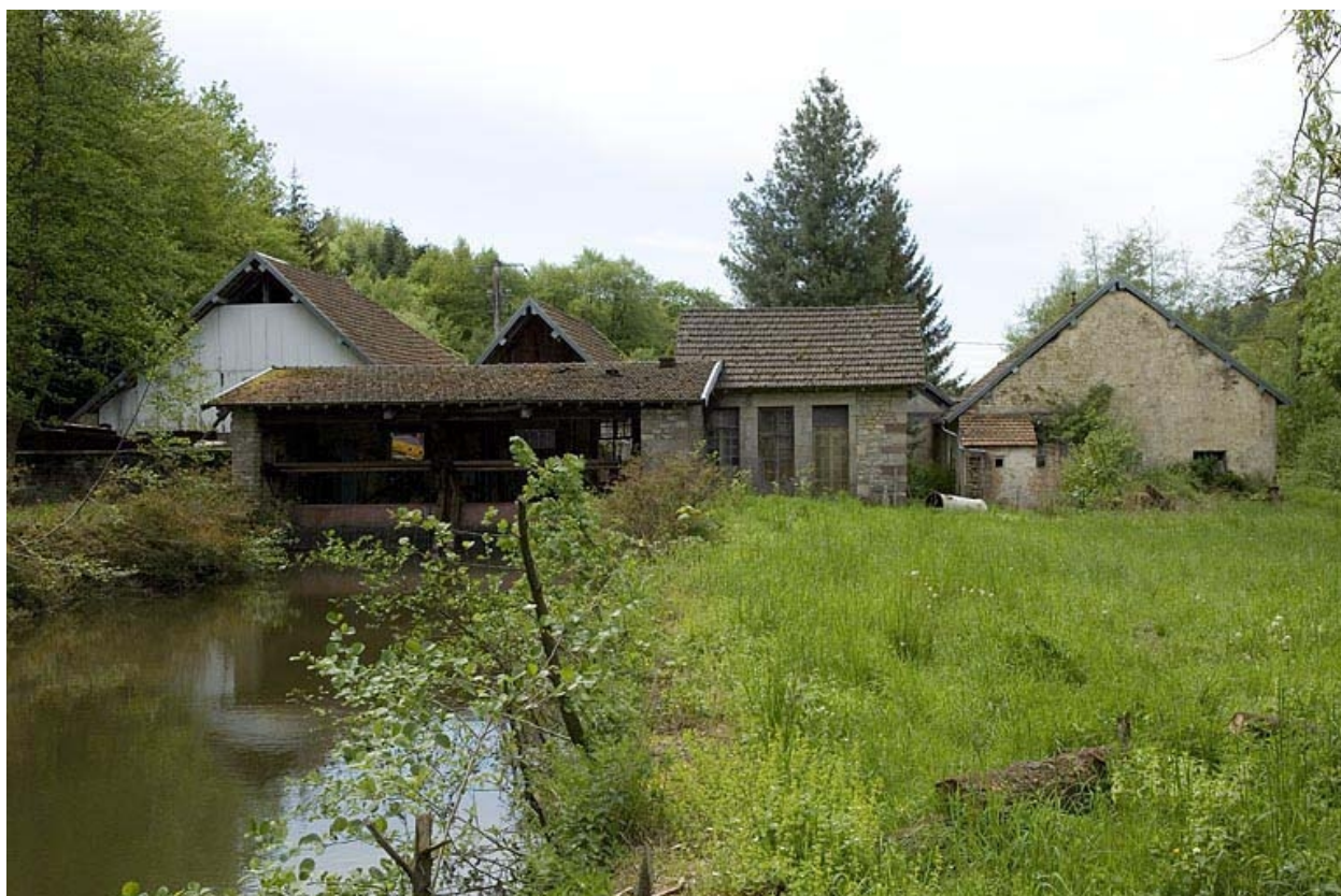
Façades postérieures depuis le bief d'amenée.
