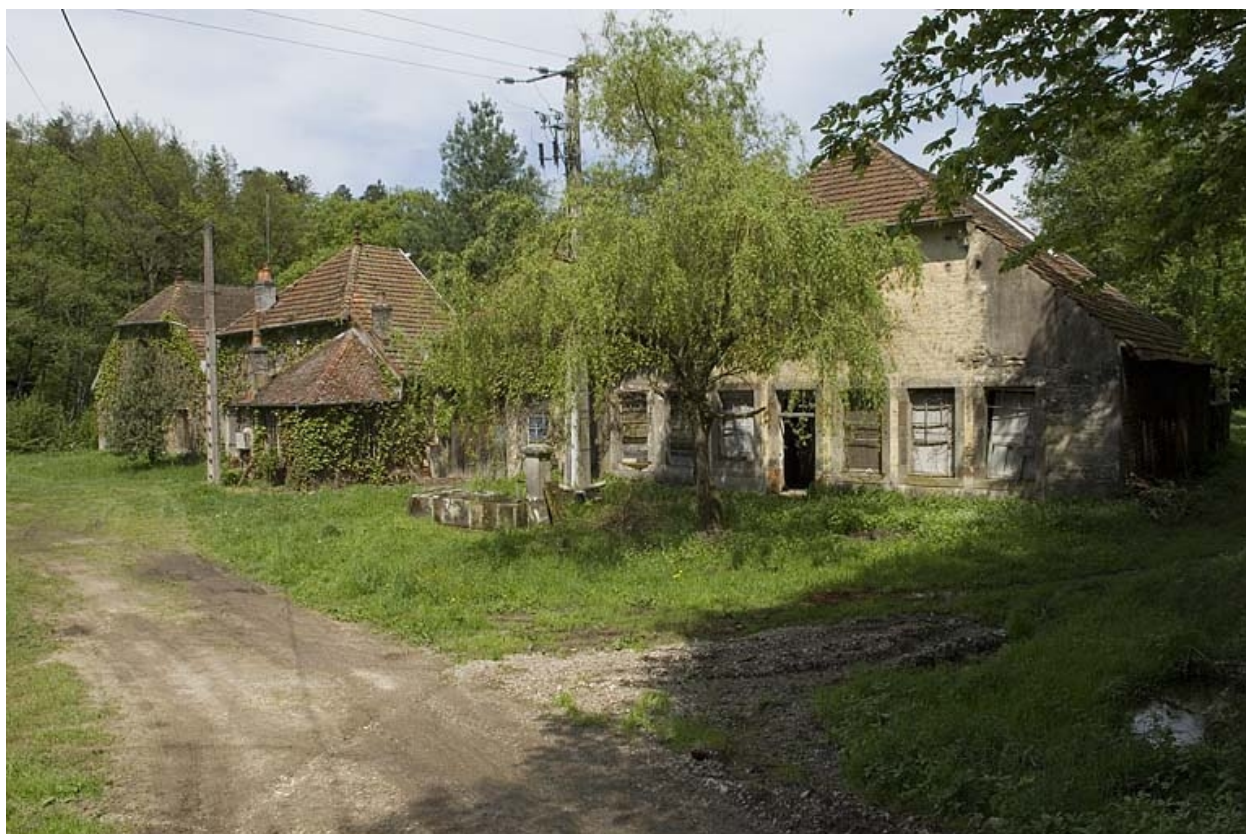
Façades antérieures depuis le sud.
