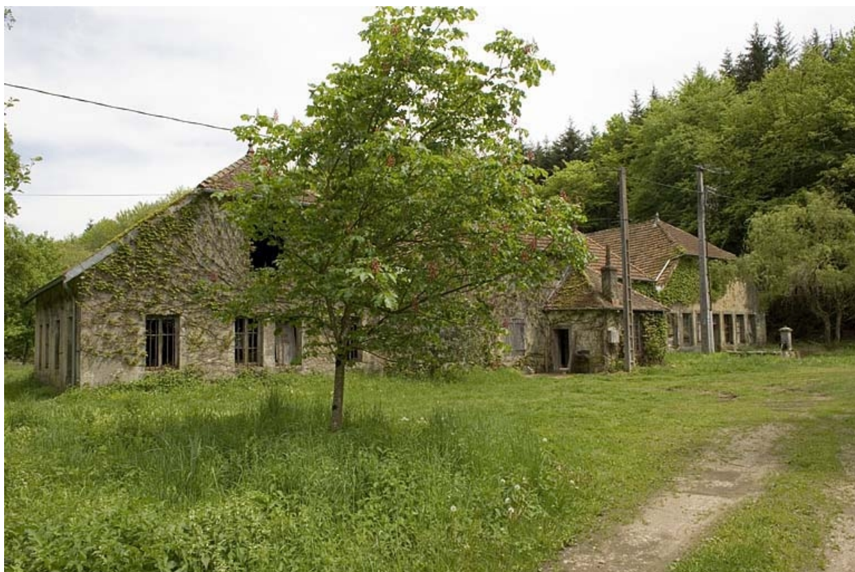
Façades antérieures depuis l'ouest.
