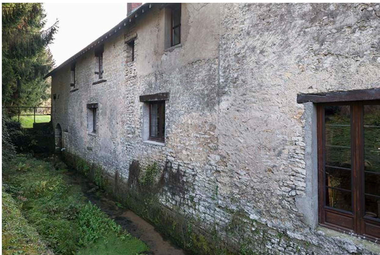
Façade est de l'atelier de forge.
