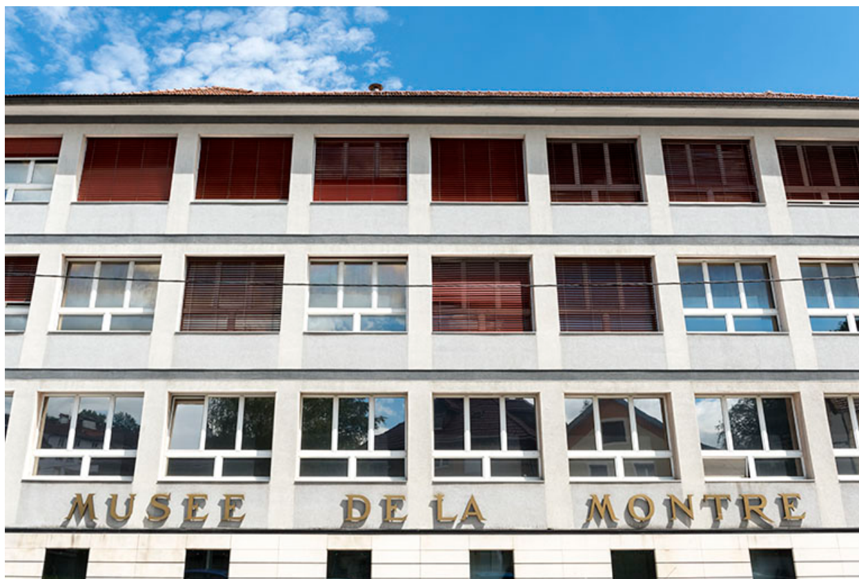
Façade antérieure, vue en contre-plongée.
