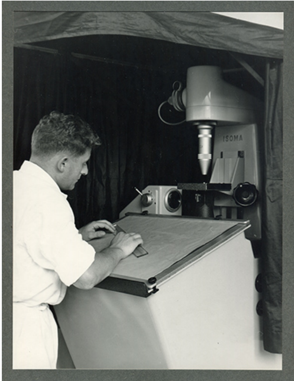
Technicien au travail sur un projecteur de profil Isoma, années 1960.
