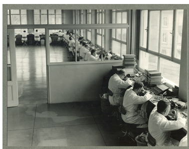
Atelier de montage, années 1960. IVR43_20182500794NUC4A
