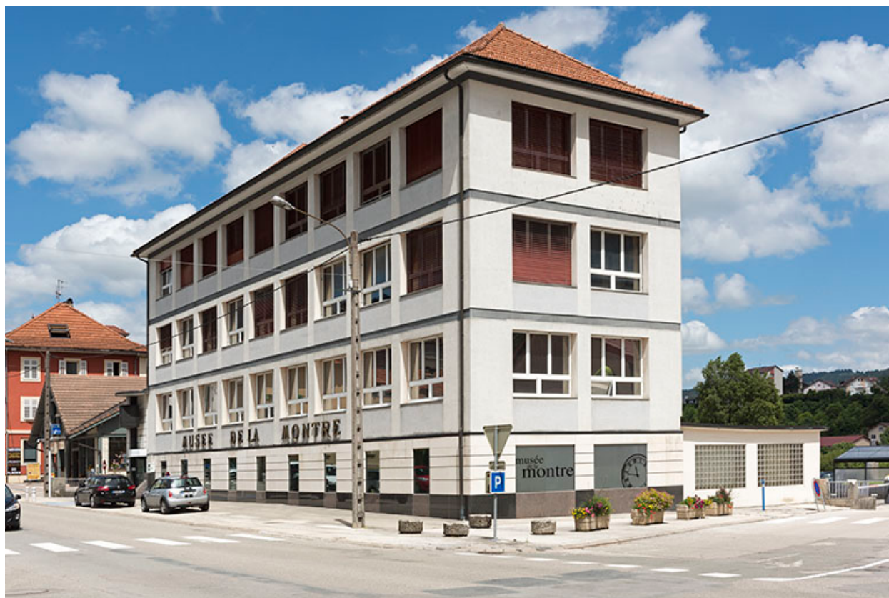
Façades antérieure et latérale droite.
