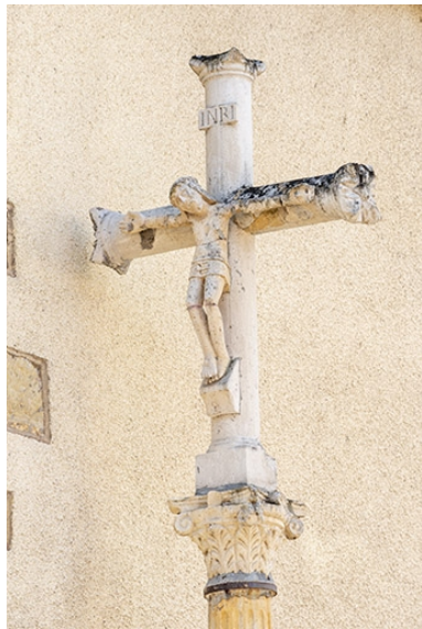
Détail de croix, trois quarts avant droit.
