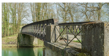
Le pont, vue d'ensemble. Phot. Pierre-Marie Barbe-Richaud IVR26_20138900033NUC4AQ
