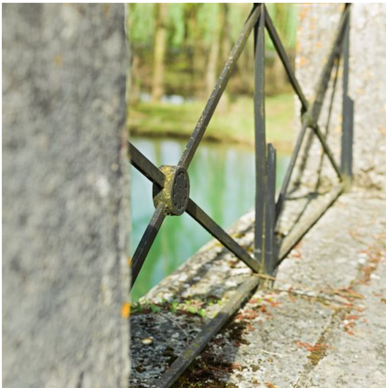
Détail du garde-corps.
