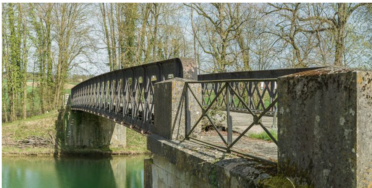
Le pont, vue d'ensemble.
