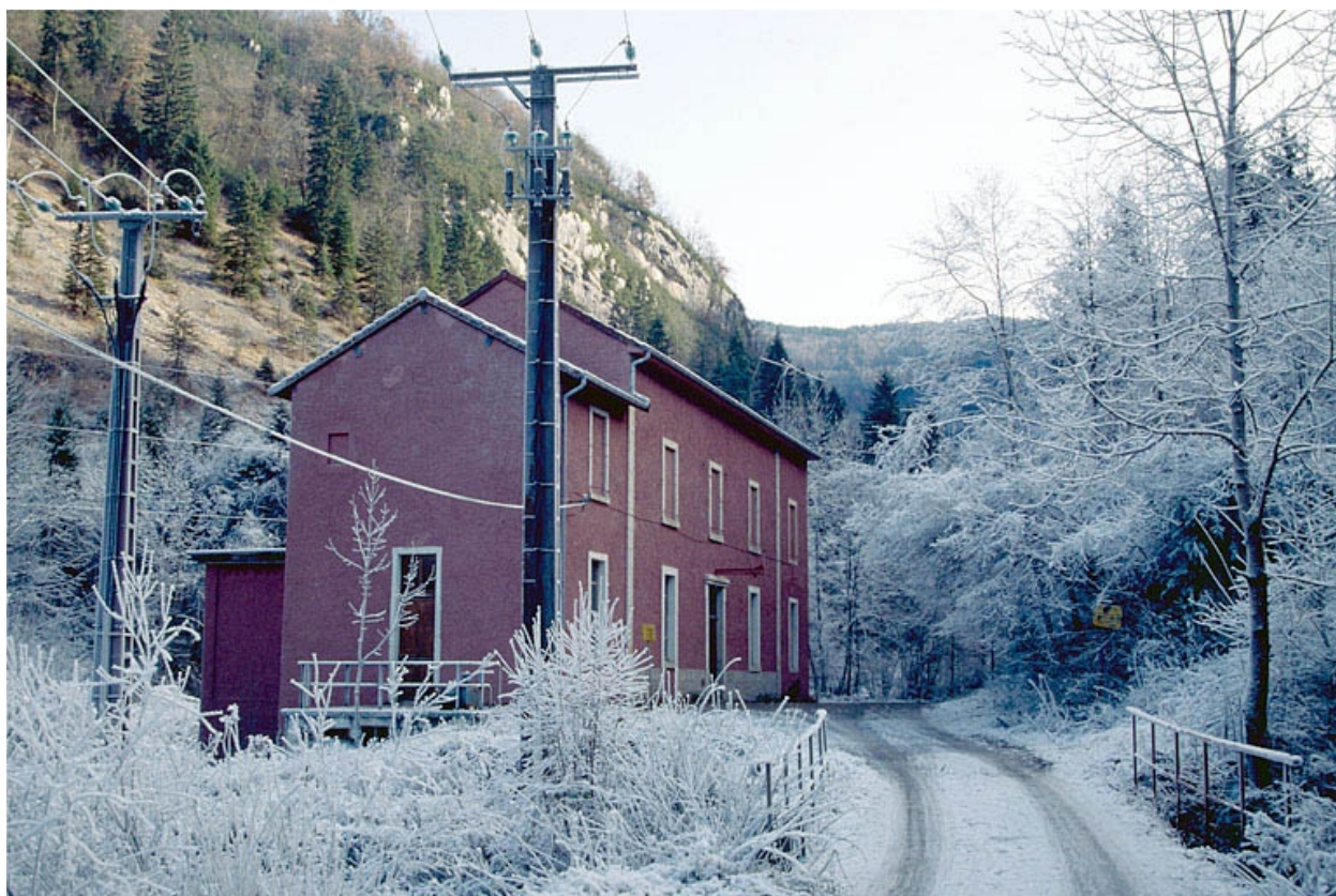
Façade antérieure et latérale gauche.
