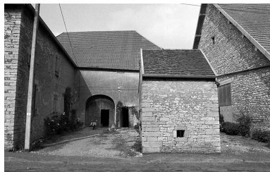
Vue de face. Phot. Bernard Lardière IVR43_19797000072Z
