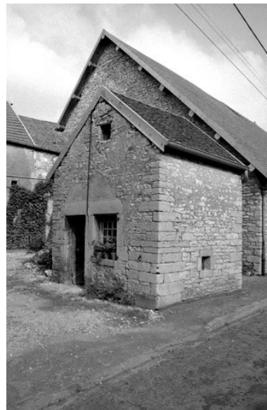
Détail : le four. Phot. Bernard Lardière IVR43_19797000073Z
