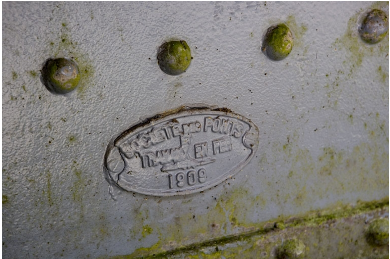
Pont : plaque du constructeur.
