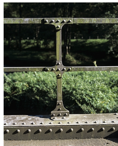
Pont : détail du garde-corps.
