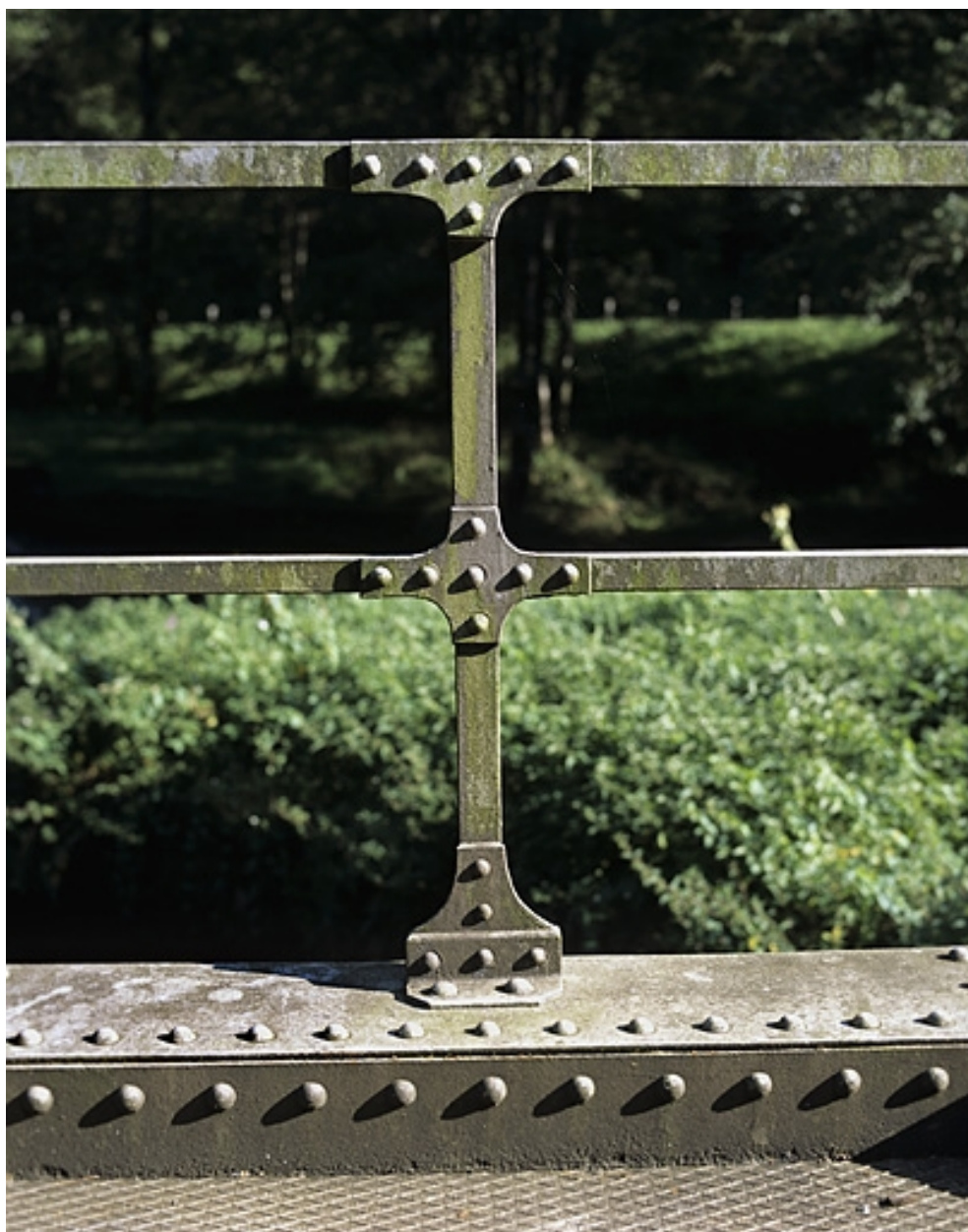
Pont : détail du garde-corps.
