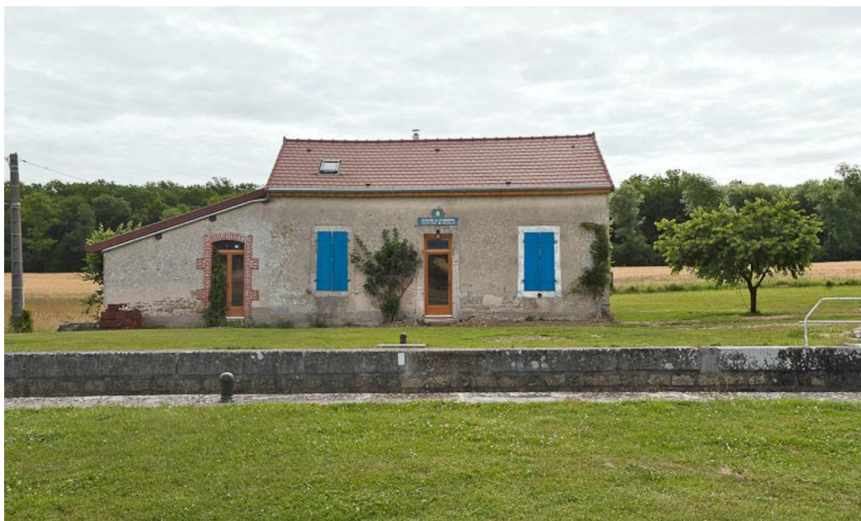
Vue de face de la maison éclusière.
