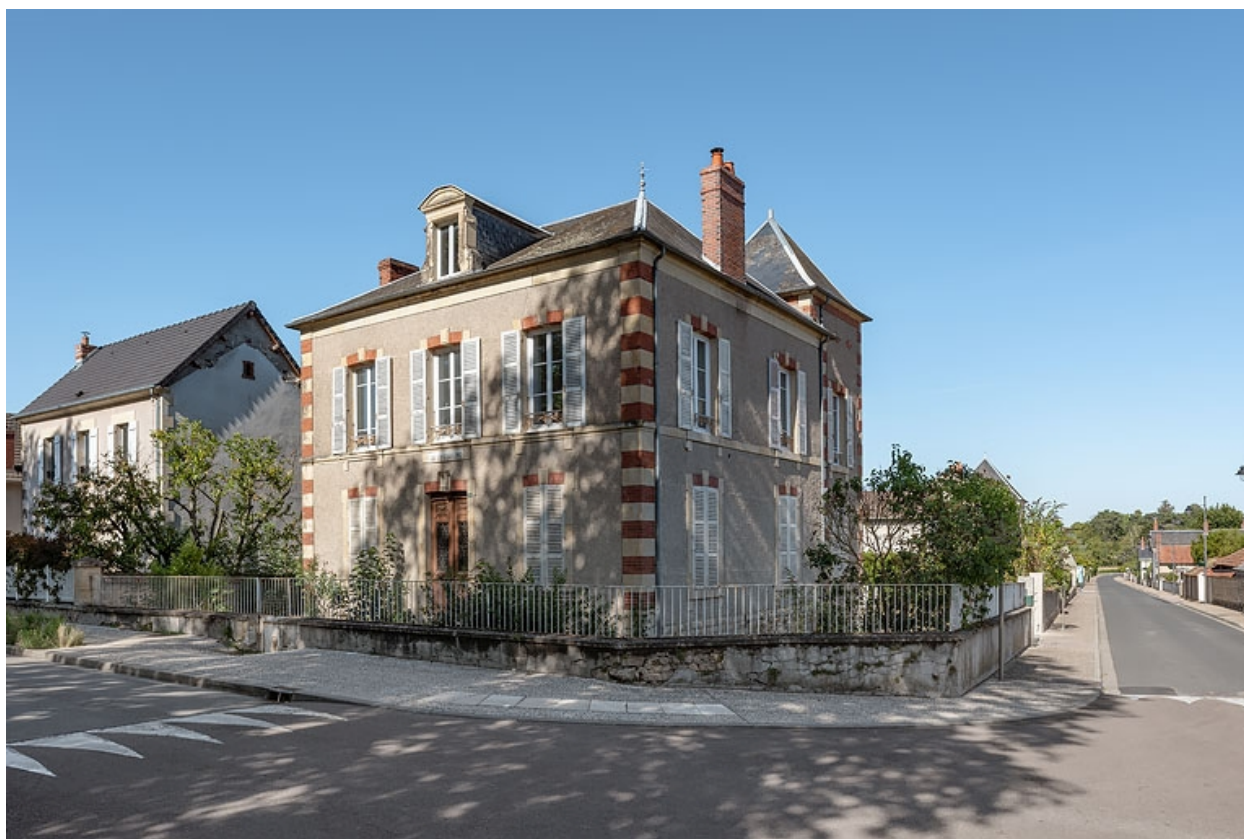
Vue depuis le sud-est.
