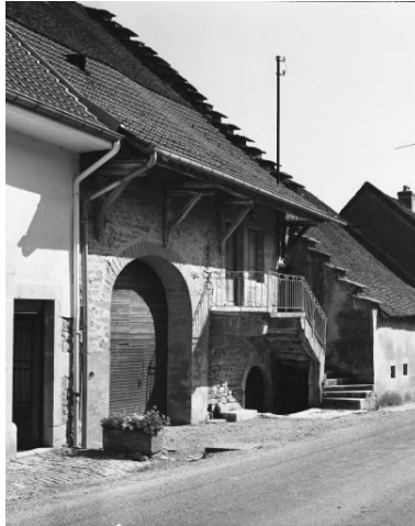
Ferme située 36 Grande Rue. Phot. Dominique Dominguez IVR43_19803900030X
