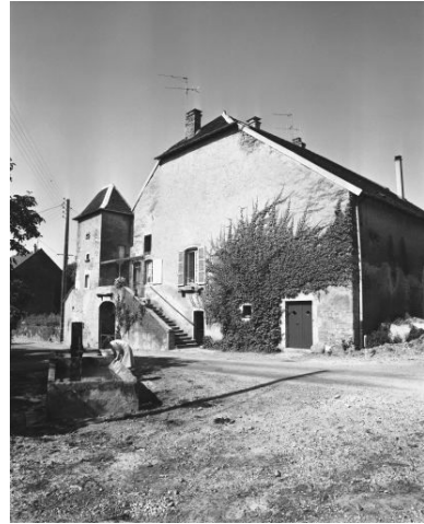
Ferme située 9 Grande Rue. Phot. Dominique Dominguez IVR43_19803900038X
