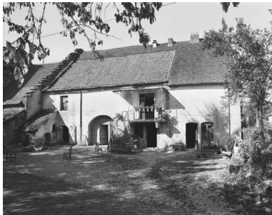
Ferme située Grande Rue. Phot. Dominique Dominguez IVR43_19803900031X
