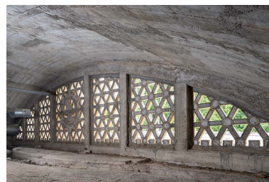
Vue de trois quarts de la claustra depuis les combles. Phot. Jérôme Mongreville IVR43_20207000345NUC4A
