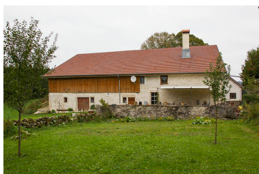
Façade latérale gauche. Phot. Yves Sancey IVR43_20132501688NUC2A
