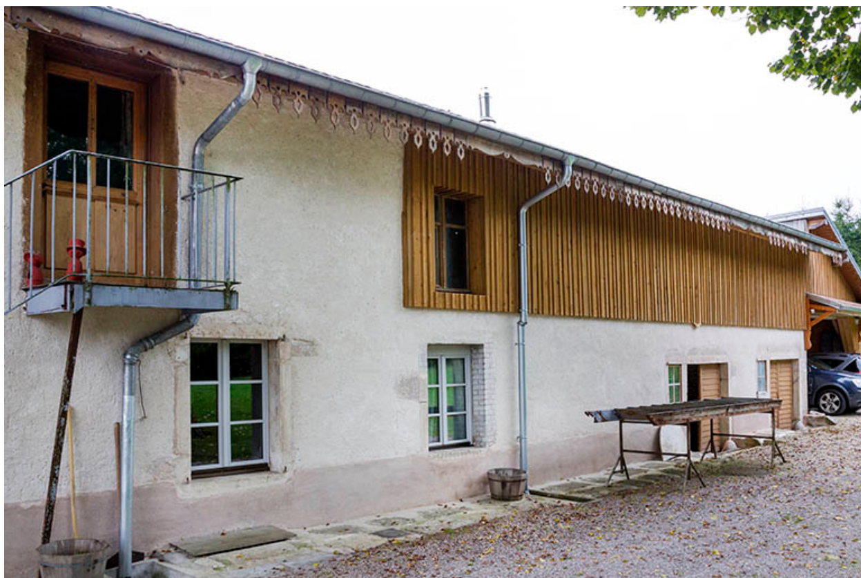
Façade latérale droite.
