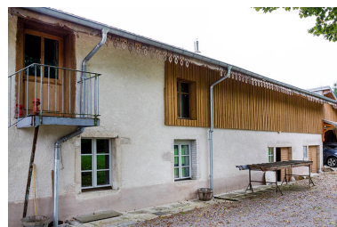
Façade latérale droite. Phot. Yves Sancey IVR43_20132501696NUC2A
