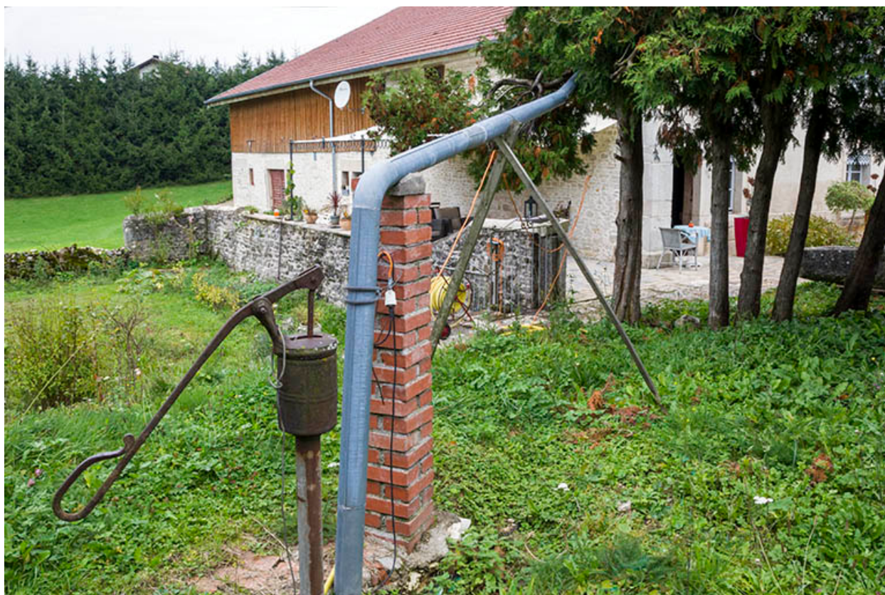
Citerne, pompe et tuyau d'amenée d'eau.
