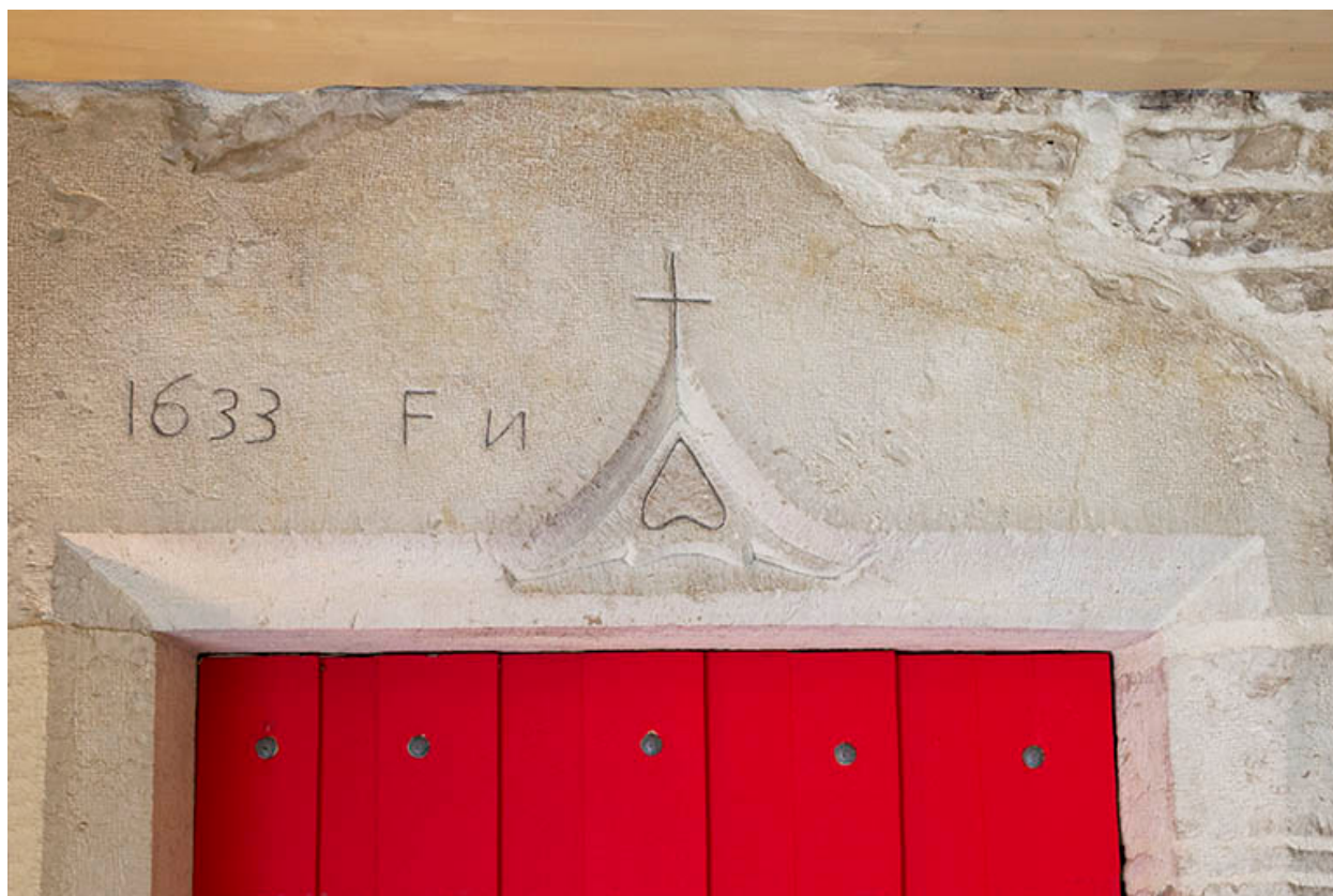
Linteau portant la date 1633, intégré au bâtiment.
