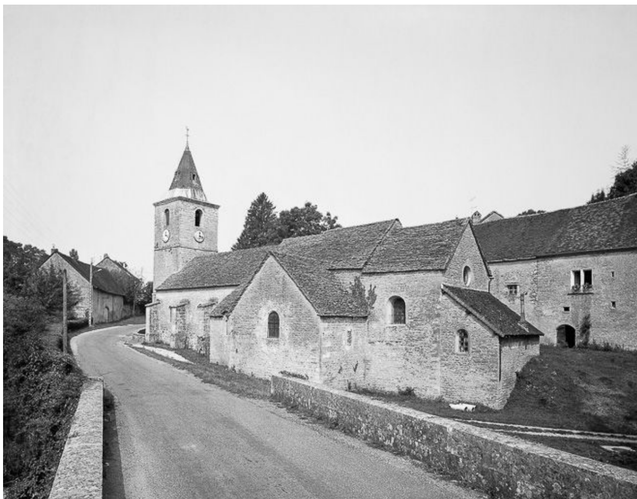
Façade latérale droite, chevet et clocher.
