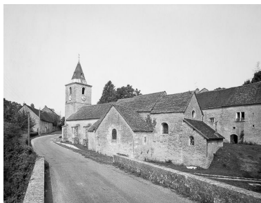
Façade latérale droite, chevet et clocher. Phot. Yves Sancey IVR43_19843900078V
