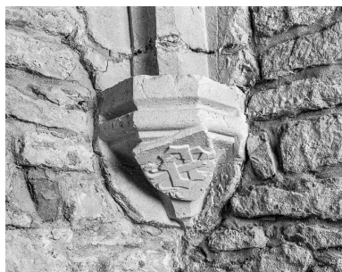
Première chapelle droite : culot sud-est. Phot. Yves Sancey IVR43_19843900096X
