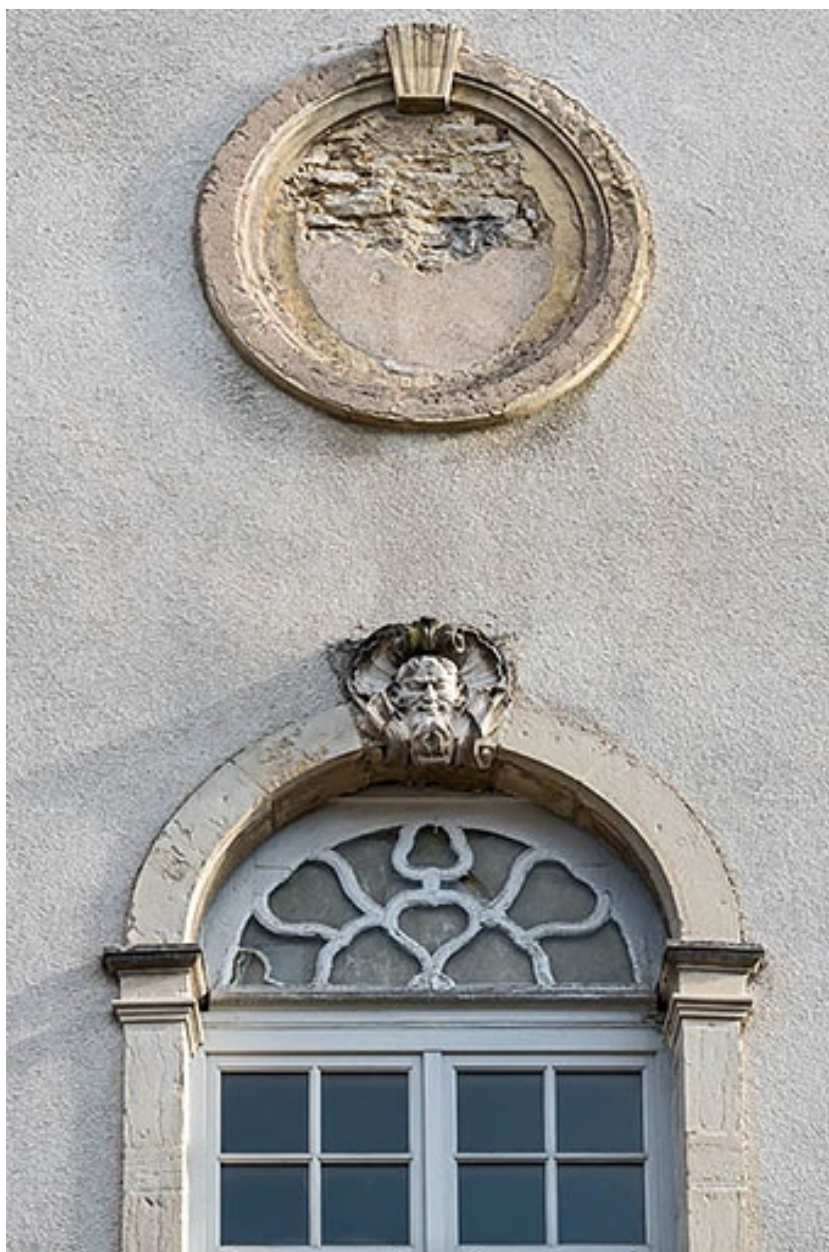
Façade antérieure, travée centrale : baies supérieures.
