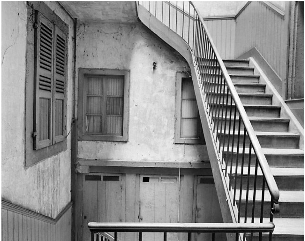
Cage d'escalier, au premier étage.
