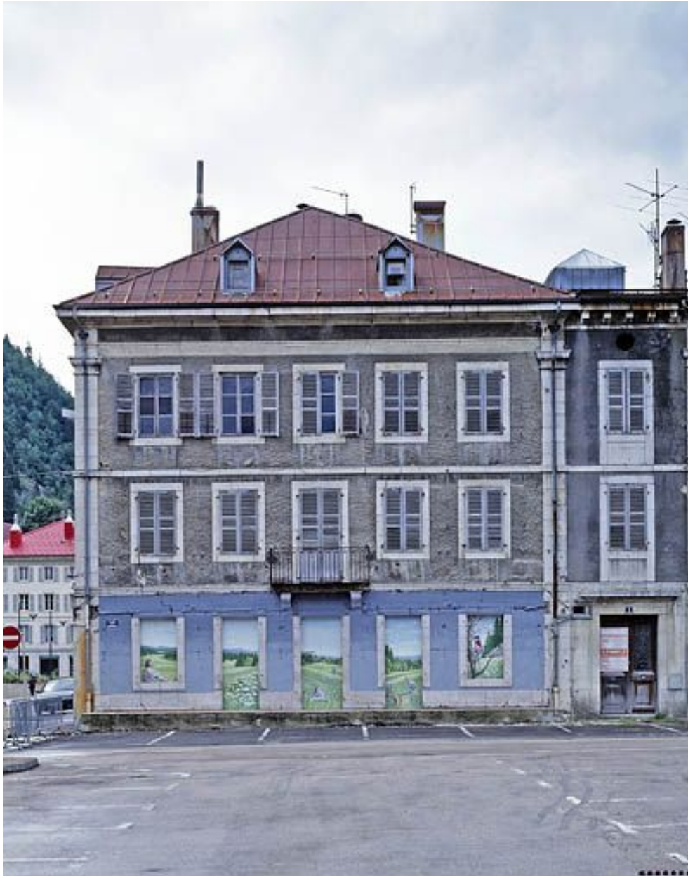
Le corps de bâtiment oriental.
