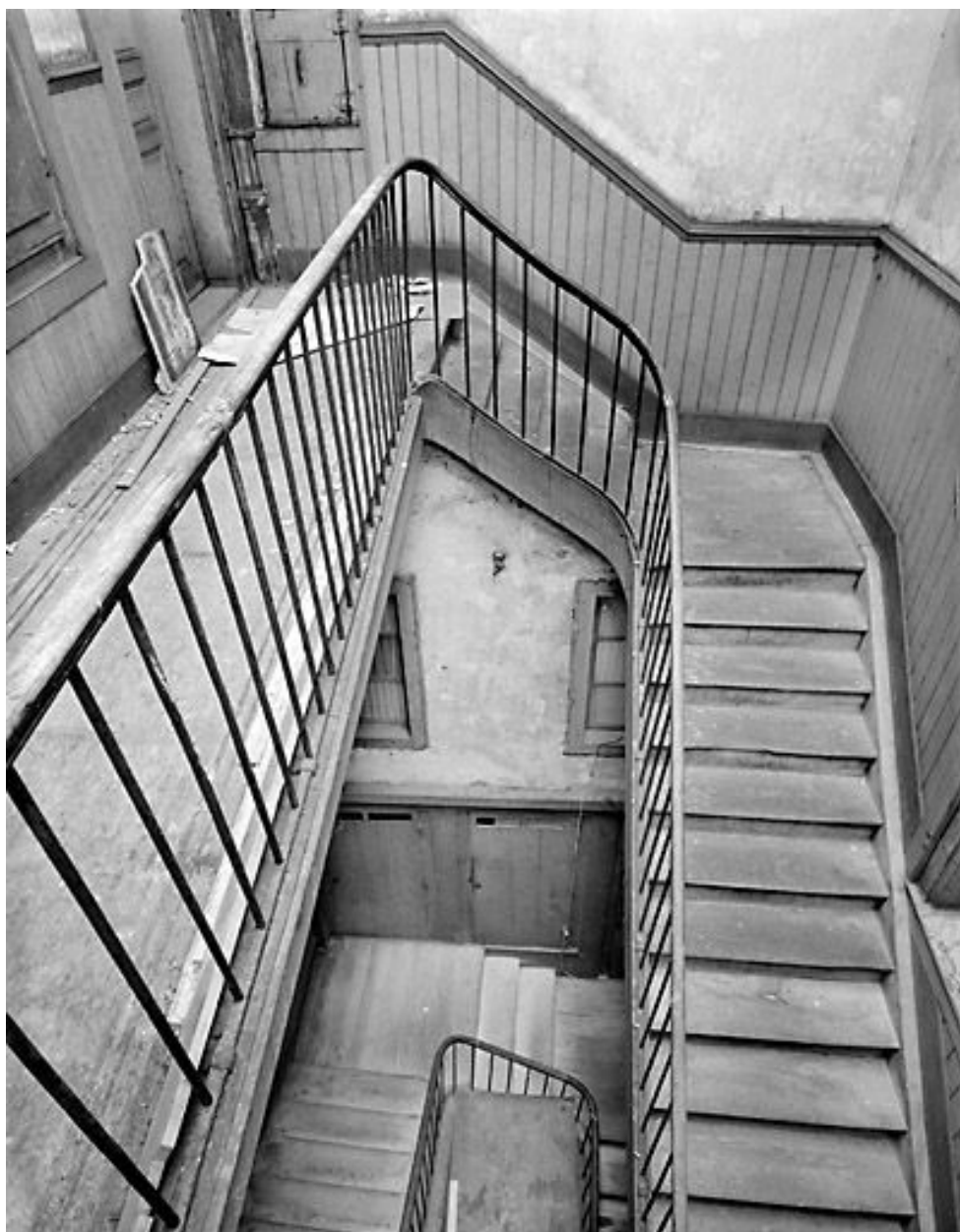
Vue plongeante sur la cage d'escalier.
