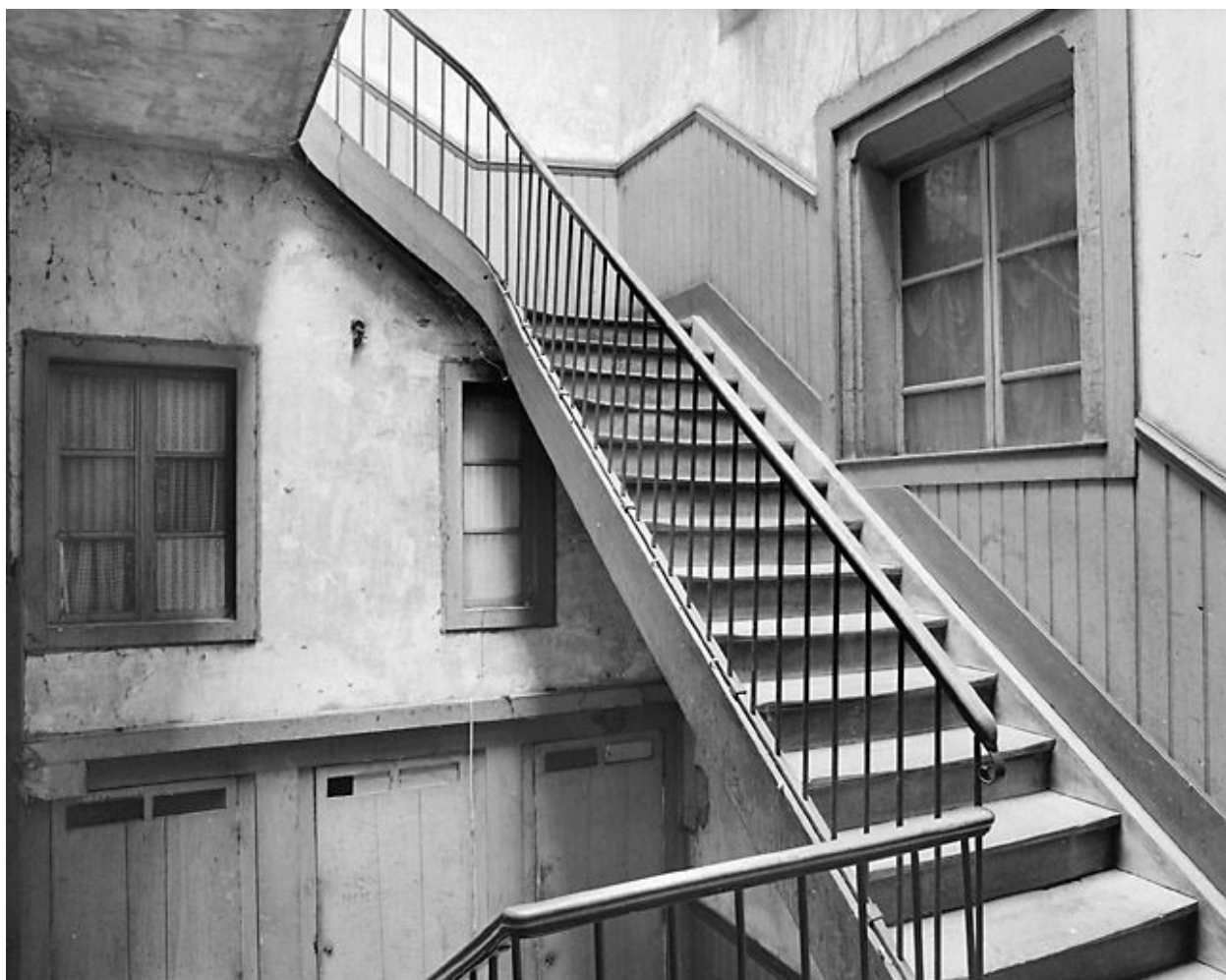
Escalier depuis le palier du premier étage.
