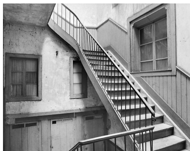
Escalier depuis le palier du premier étage. Phot. Jérôme Mongreville IVR43_20003900380X
