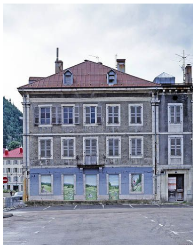
Le corps de bâtiment oriental.
