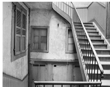
Cage d'escalier, au premier étage. Phot. Jérôme Mongreville IVR43_20003900378X
