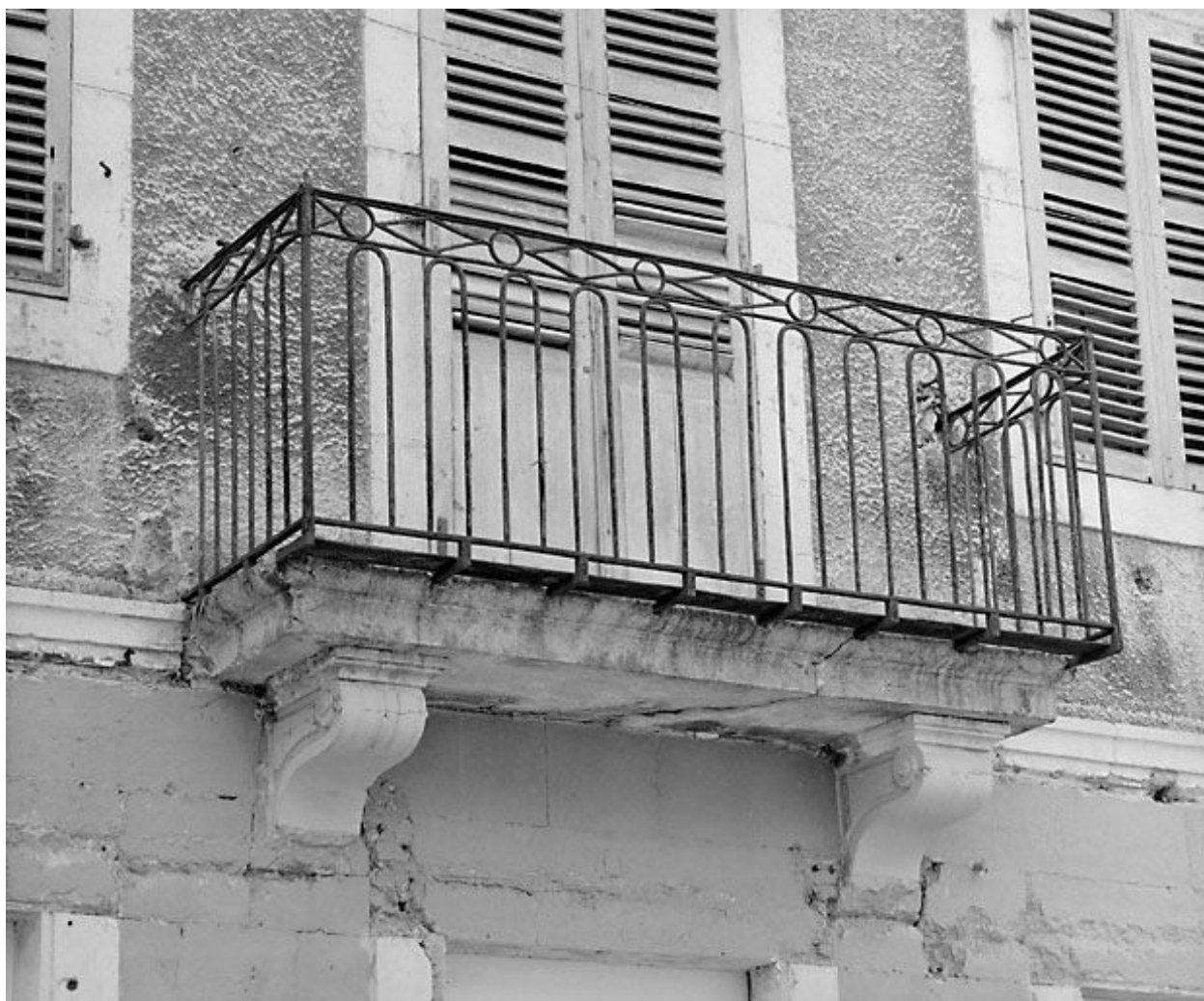
Balcon du corps de bâtiment oriental.
