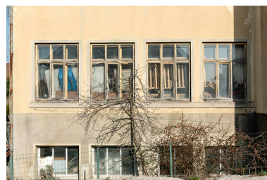
Aile orientale : fenêtres multiples. Phot. Sonia Dourlot IVR43_20192500406NUC4A
