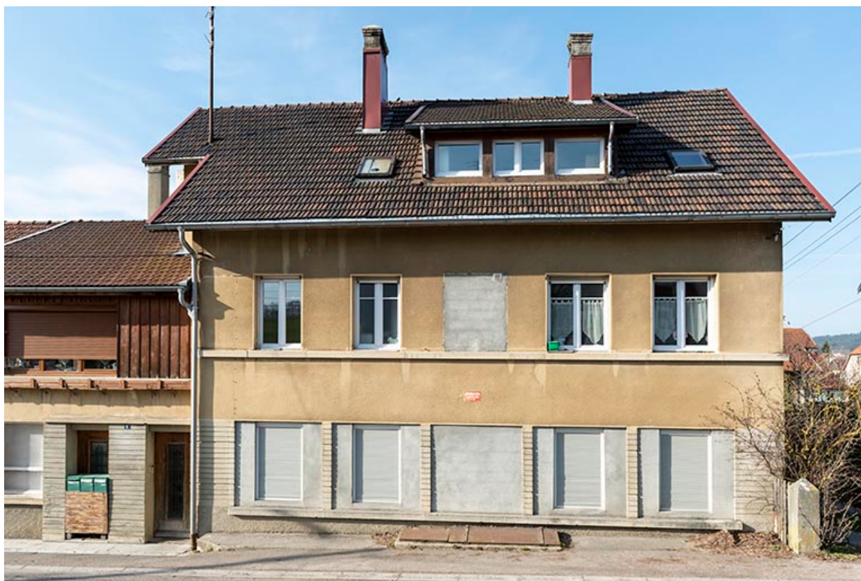
Façade antérieure de l'atelier.
