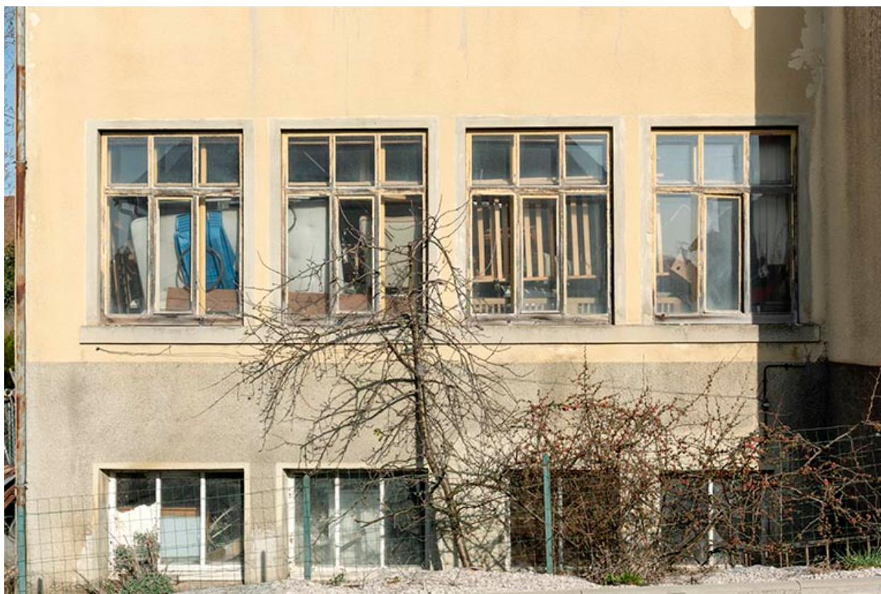
Aile orientale : fenêtres multiples.
