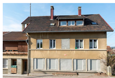
Façade antérieure de l'atelier. Phot. Sonia Dourlot IVR43_20192500402NUC4A
