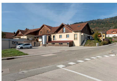
Façades postérieure et latérale gauche.
