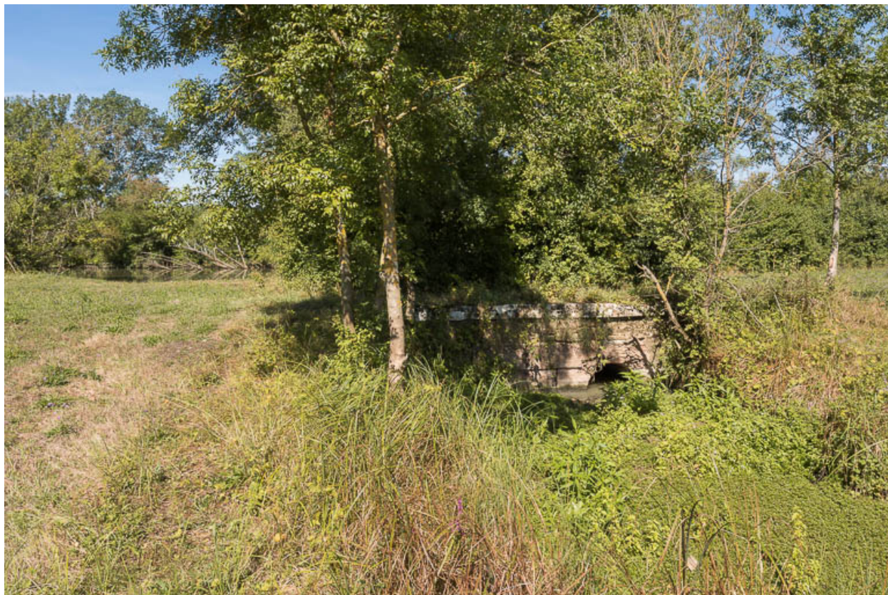
Vue du ponceau.
