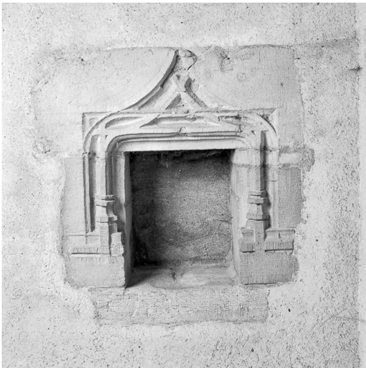
Niche dans un mur intérieur.
