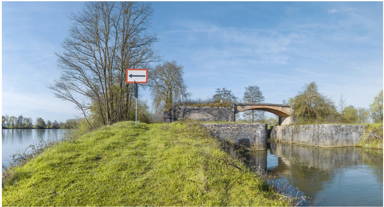
L'entrée de l'ancienne dérivation, rive droite.
