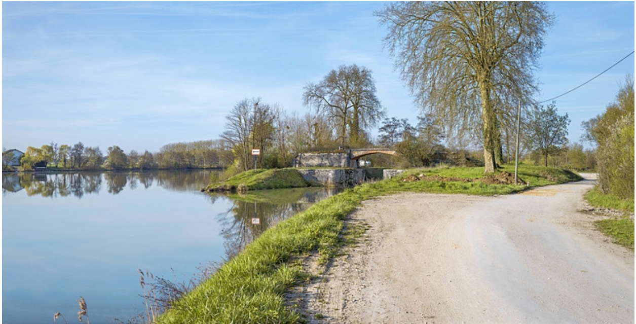
L'entrée de l'ancienne dérivation, rive droite.
