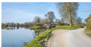
L'entrée de l'ancienne dérivation, rive droite.
