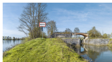
L'entrée de l'ancienne dérivation, rive droite.
