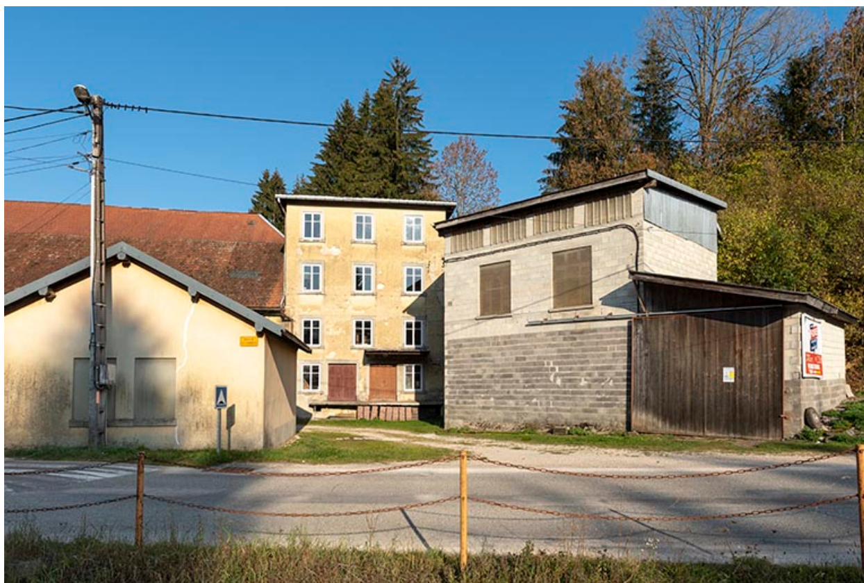
Garage, minoterie et silos.
