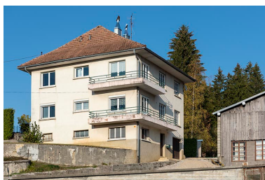
Maison de 1960. Phot. Sonia Dourlot IVR43_20182501725NUC4A
