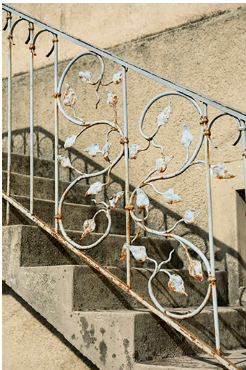
Maison de 1924 : ferronnerie du garde-corps de l'escalier.
