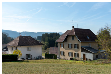
Maisons, depuis le nord-est. Phot. Sonia Dourlot IVR43_20182501722NUC4A
