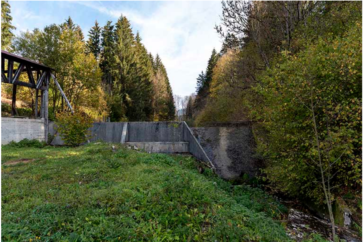
Bassin de retenue.
