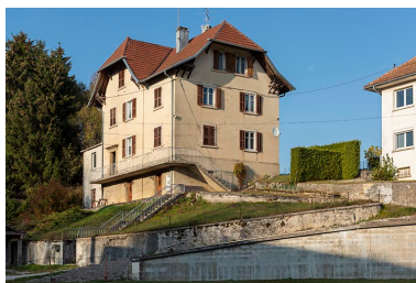
Maison de 1924. Phot. Sonia Dourlot IVR43_20182501721NUC4A
