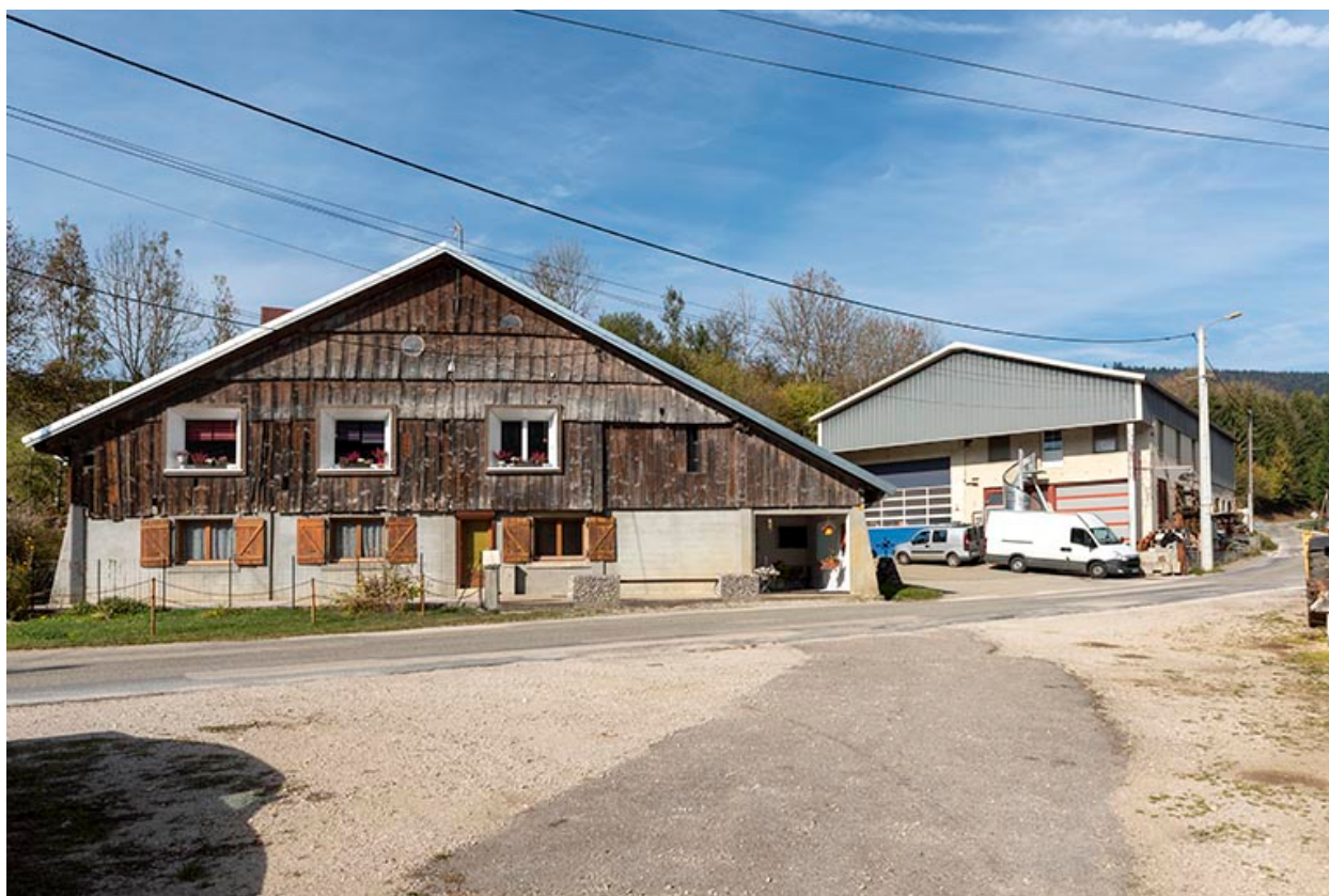
Ancienne ferme et "caisserie".
