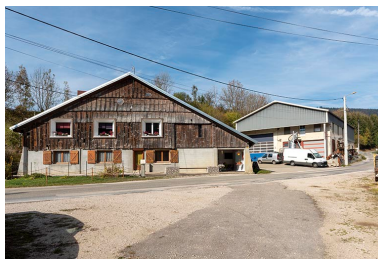
Ancienne ferme et "caisserie". Phot. Sonia Dourlot IVR43_20182501718NUC4A
