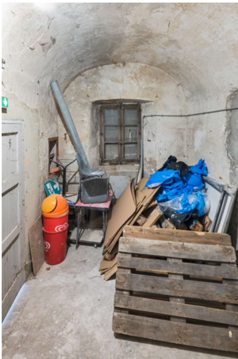
Corps nord-ouest : pièce voûtée au rez-de-chaussée.
