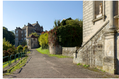
Ruines d'une tour près de l'église. Phot. Sonia Dourlot IVR43_20157000578NUC2A
