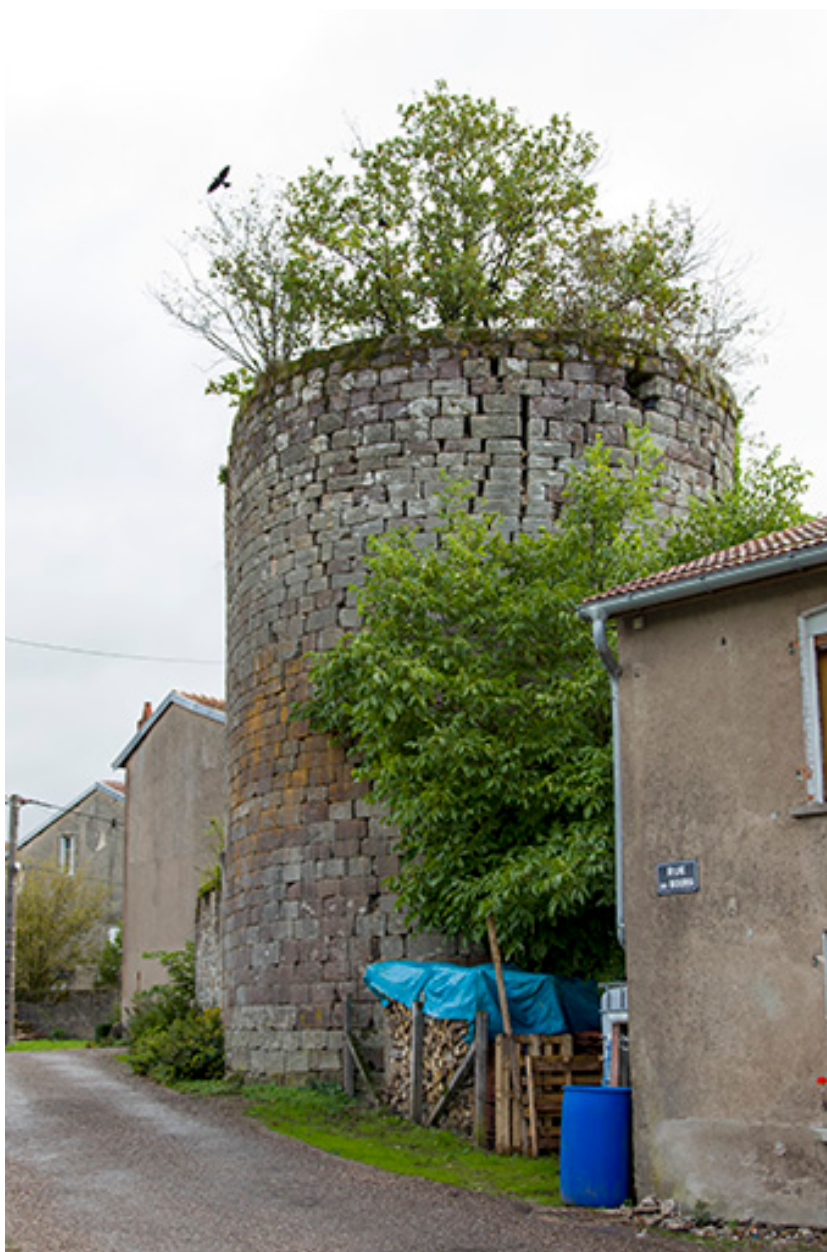
L'ancienne tour d'entrée de ville.
