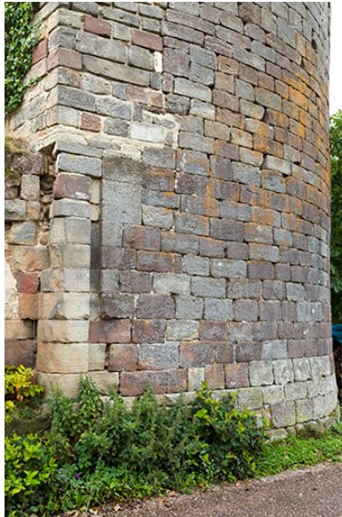
Détail d'une rainure verticale qui accueillait la herse permettant de fermer la porte. Phot. Sonia Dourlot IVR43_20157000575NUC2A
