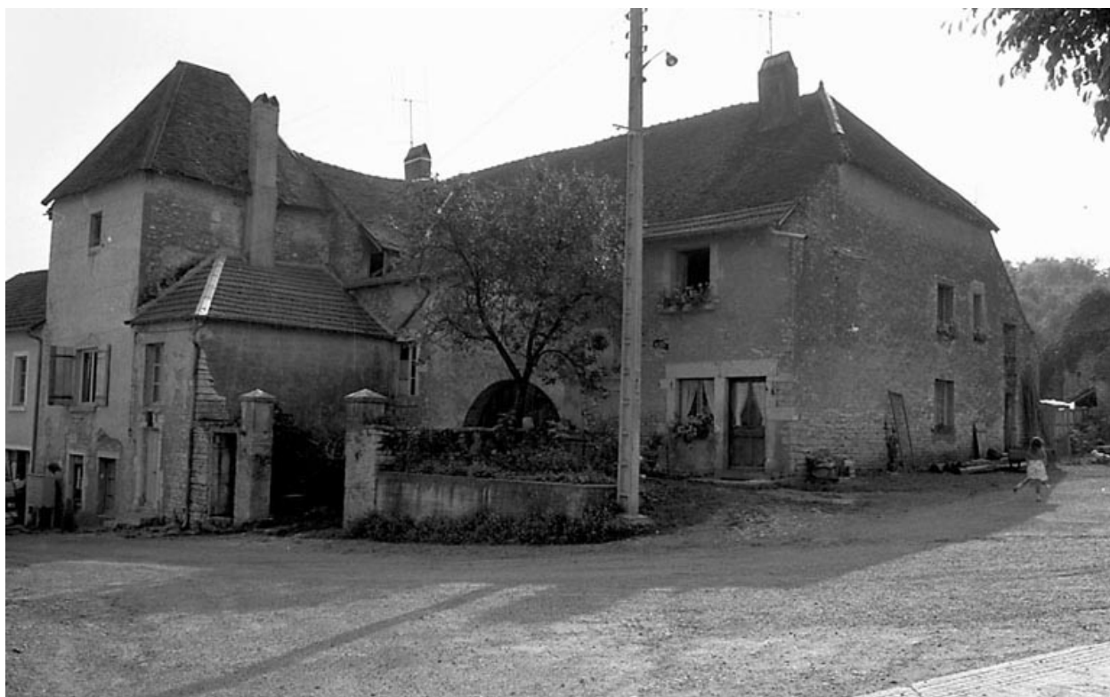
Demeure située rue de l'Eglise.
