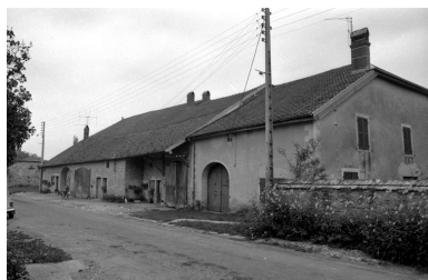
Ferme située 5 Grande Rue. Phot. Bernard Lardière IVR43_19797000086Z
