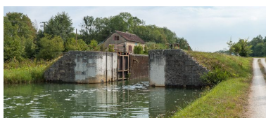
Vue d'aval. Phot. Pierre-Marie Barbe-Richaud IVR26_20128900555NUC4AQ
