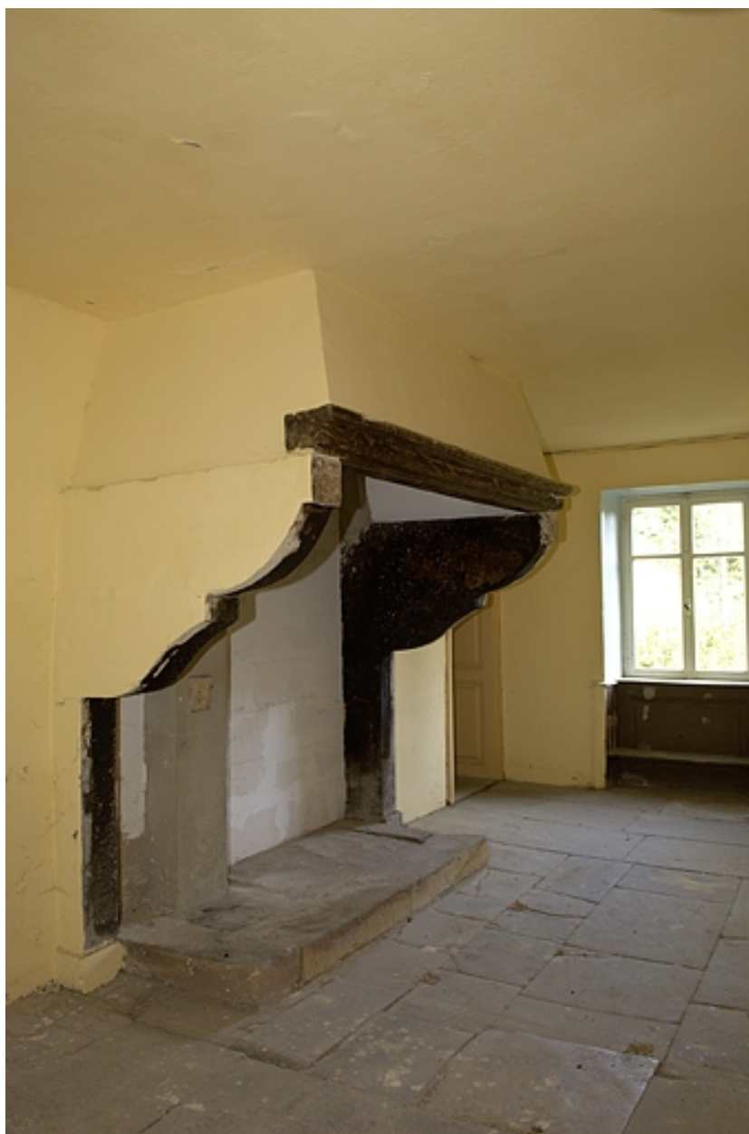
Logement. Cheminée de la cuisine.
