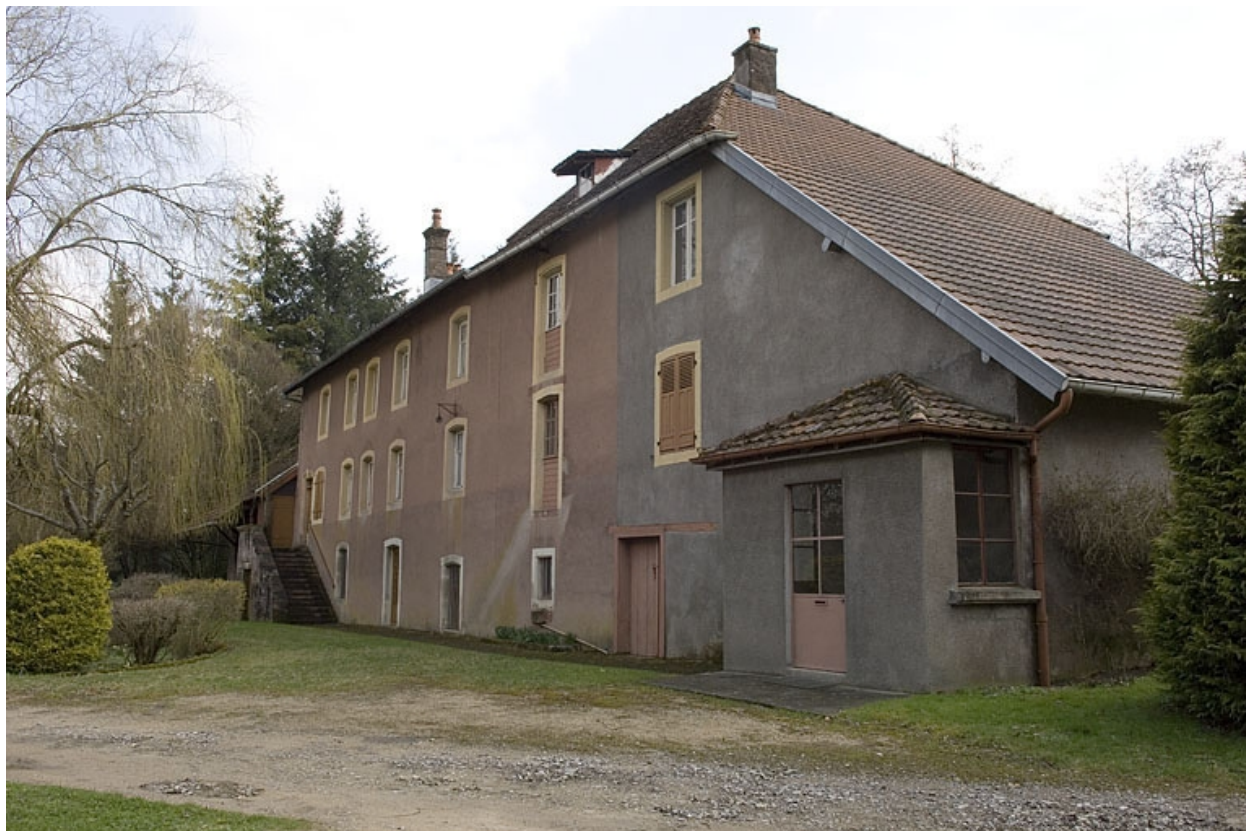
Façade antérieure depuis l'ouest.
