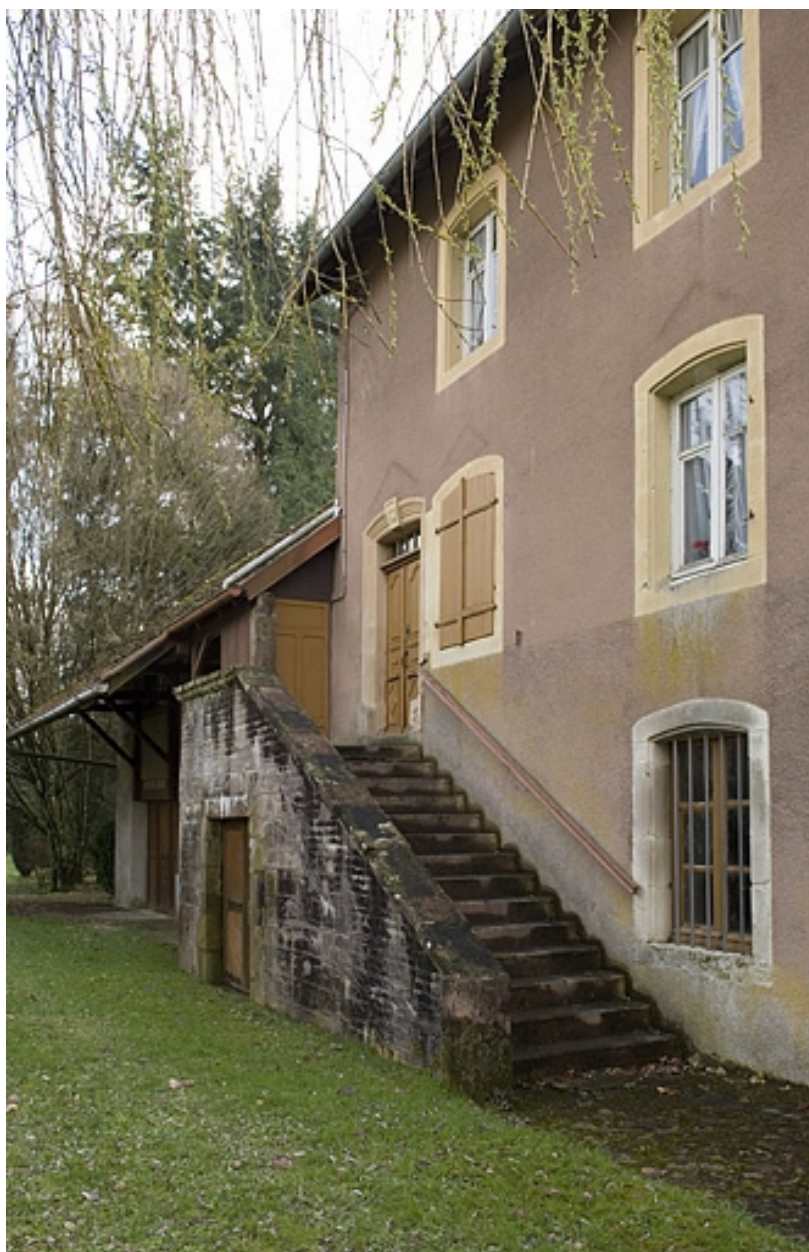
Façade antérieure. Escalier d'accès au logement.
