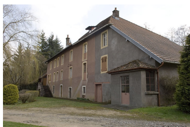
Façade antérieure depuis l'ouest. Phot. Jérôme Mongreville IVR43_20067000173NUCA
