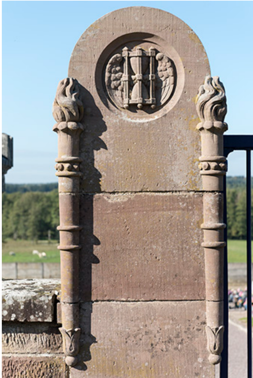
Détail du pilier gauche du portail d'entrée.
