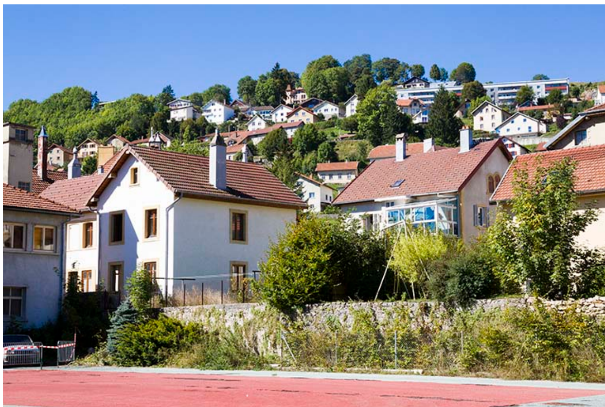
Ancien atelier, vu du sud-est. Au centre, façade postérieure de l'atelier Mauvais-Bécoulet.
