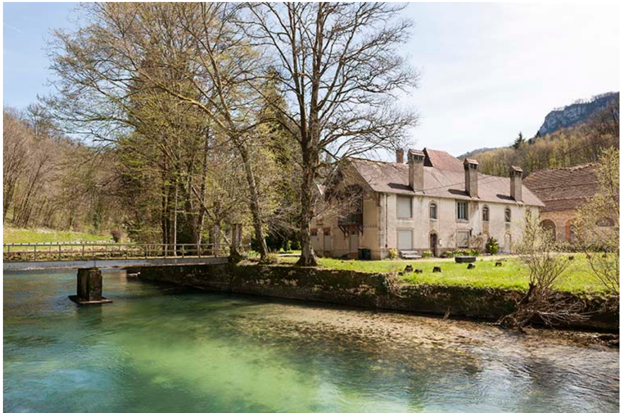
Logement patronal depuis le nord-ouest.
