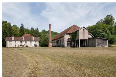
Vue rapprochée depuis l'ouest. Phot. Jérôme Mongreville IVR43_20152501481NUC4A
