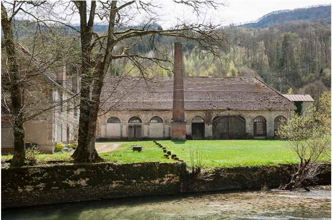
Façade nord de l'atelier de fabrication.
