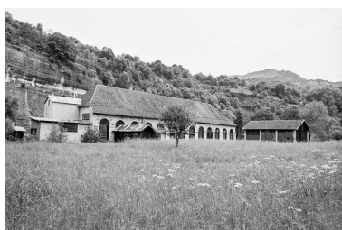
Vue d'ensemble depuis le sud en 1980. Phot. Bernard Lardière IVR43_19802500408Z
