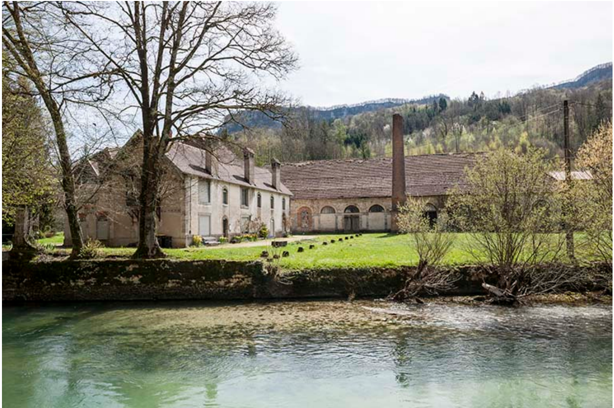
Logement et atelier depuis le nord.
