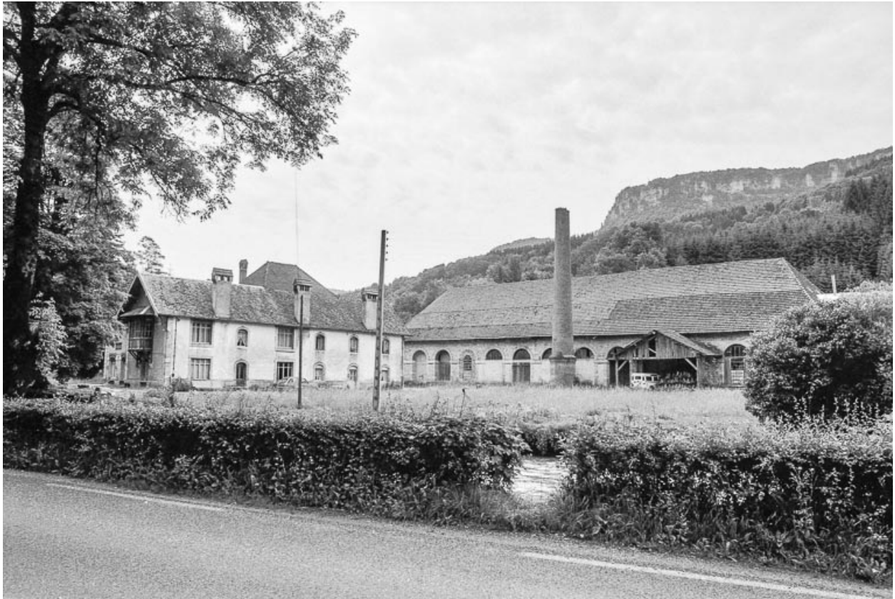
Vue d'ensemble depuis la rive droite en 1980.
