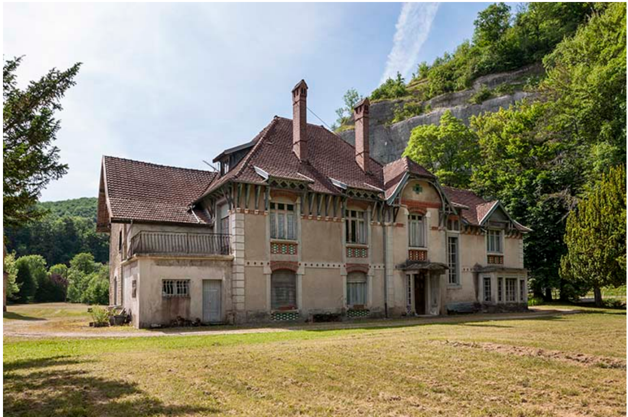
Façade est du logement patronal.
