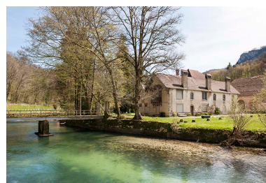
Logement patronal depuis le nord-ouest. Phot. Jérôme Mongreville IVR43_20152501071NUC4A
