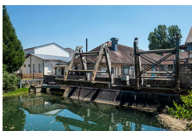
Canal d'amenée et dégrilleur de la centrale hydroélectrique. Phot. Jérôme Mongreville IVR43_20152501373NUC4A
