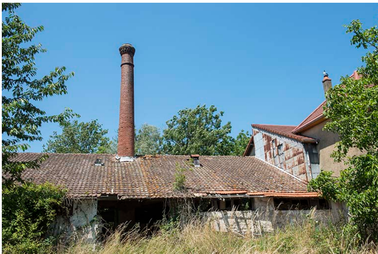
Bâtiment et cheminée de la porcherie.
