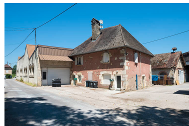
Ateliers et logement depuis la rue. Phot. Jérôme Mongreville IVR43_20152501370NUC4A
