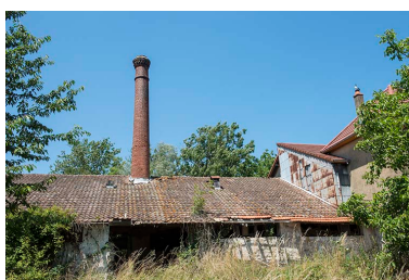
Bâtiment et cheminée de la porcherie. Phot. Jérôme Mongreville IVR43_20152501375NUC4A
