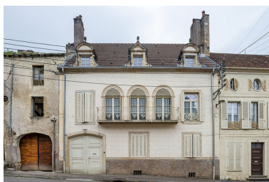
La façade antérieure. Phot. Jérôme Mongreville IVR43_20217000229NUC4A
