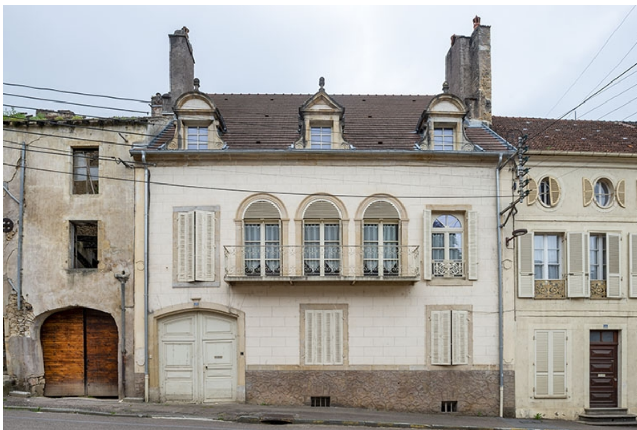
La façade antérieure.
