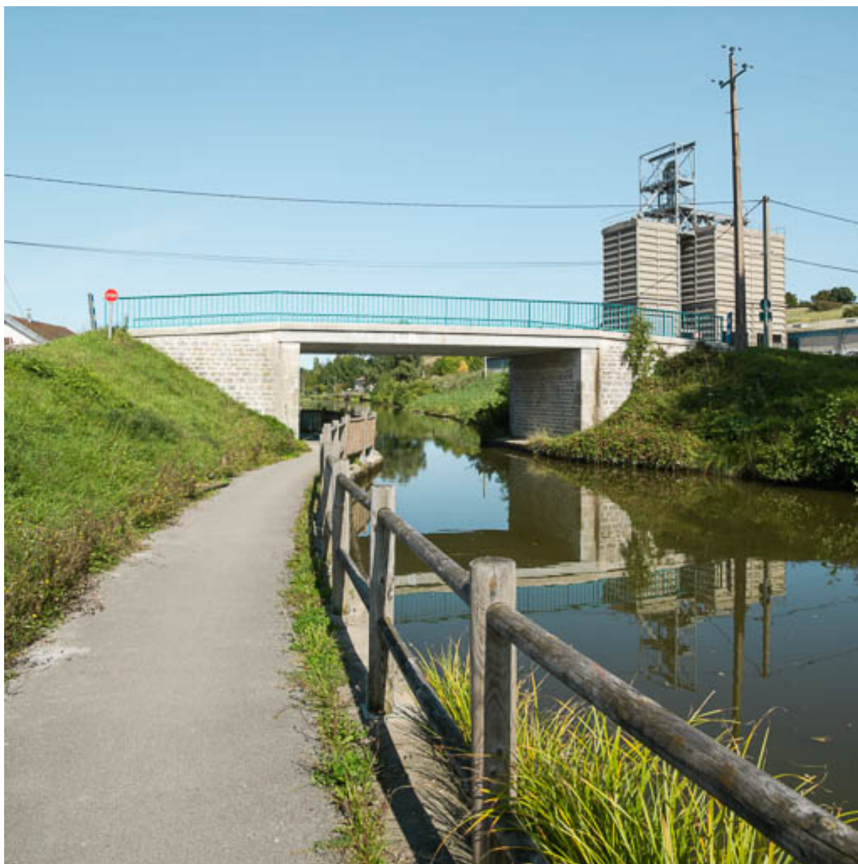
Vue d'ensemble du pont.
