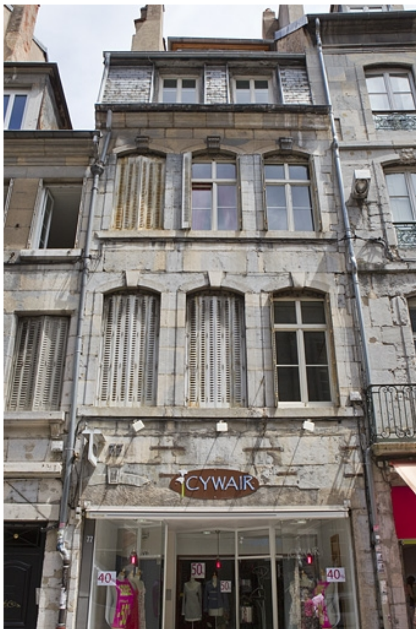
Logis principal, façade sur rue : de face.
