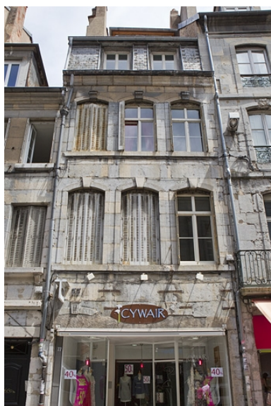
Logis principal, façade sur rue : de face. Phot. Yves Sancey IVR43_20102501158NUC2A
