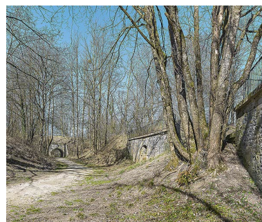
Traverse-abri, rue des Remparts.
