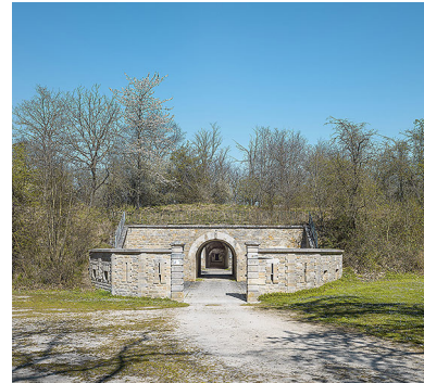
Entrée de la redoute, front de gorge. Phot. Thierry Kuntz IVR26_20252100108NUC4A
