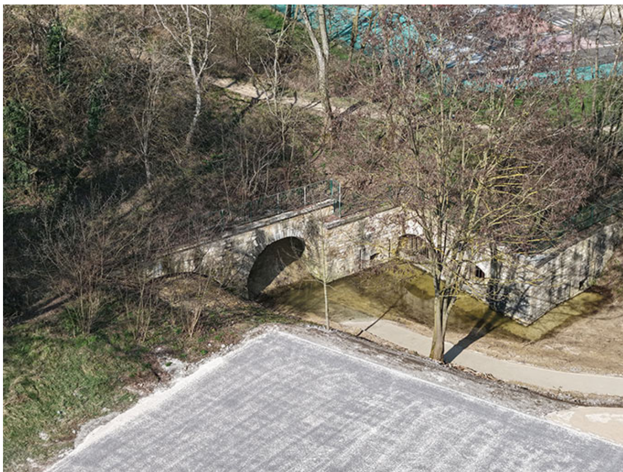
La double caponnière et le passage voûté vers la rue des Remparts (à gauche). (vue aérienne).
