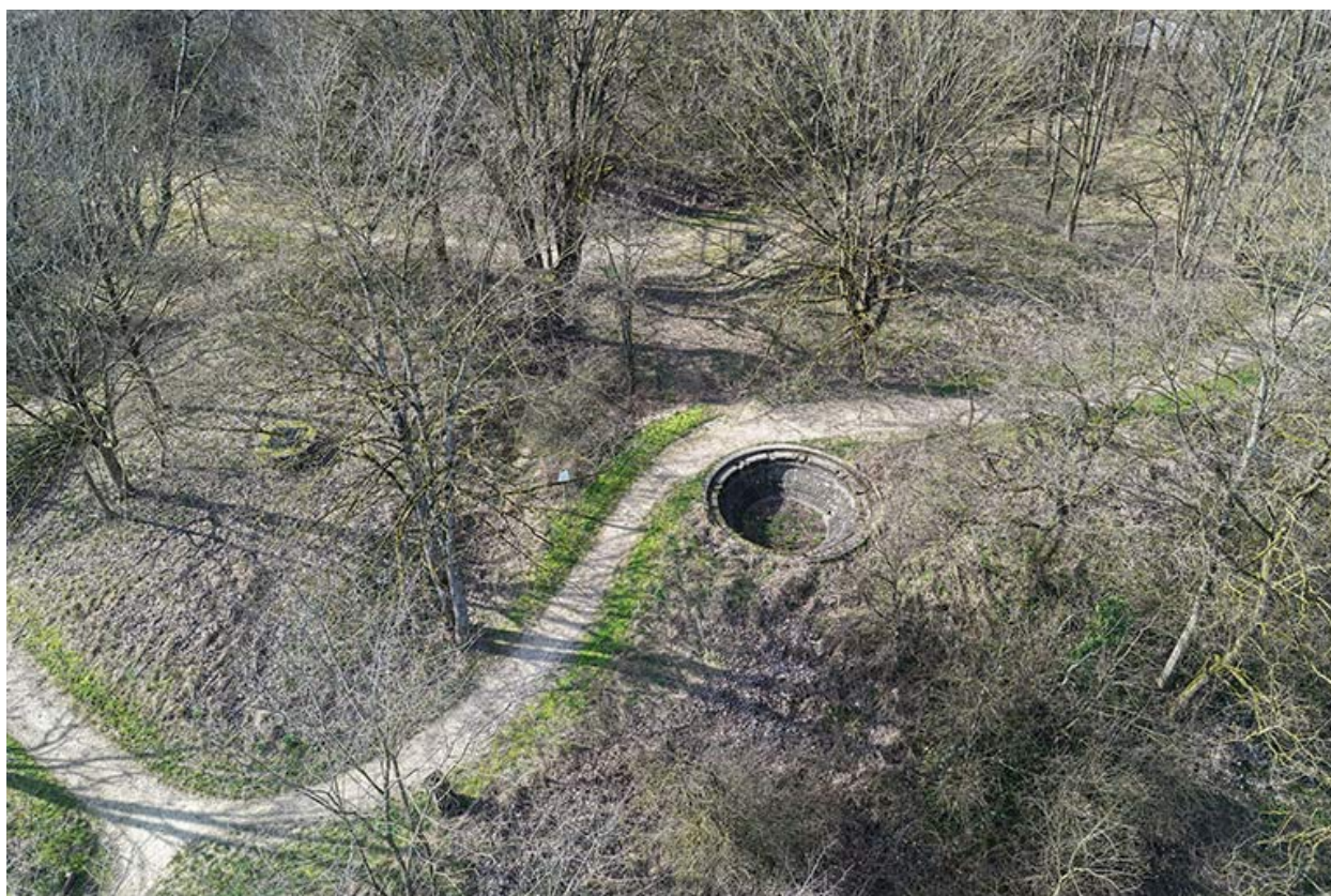
Vue aérienne d'une cuve pour canon anti-aérien. (vue aérienne).
