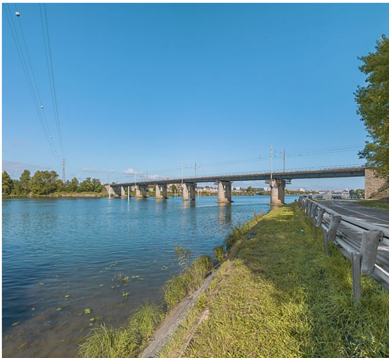
Pont ferroviaire de Mâcon (71).
