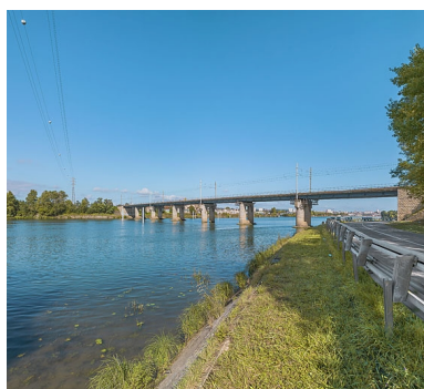
Pont ferroviaire de Mâcon (71). Phot. Thierry Kuntz IVR26_20217100583NUC4A
