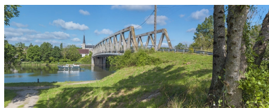
Le pont de Lamarche-sur-Saône (21). Phot. Thierry Kuntz IVR26_20162101301NUC4A
