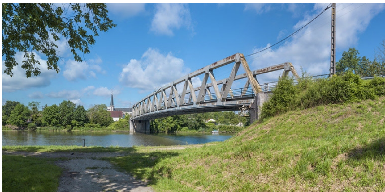
Pont routier de Lamarche-sur-Saône (21).
