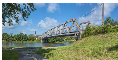
Pont routier de Lamarche-sur-Saône (21).
