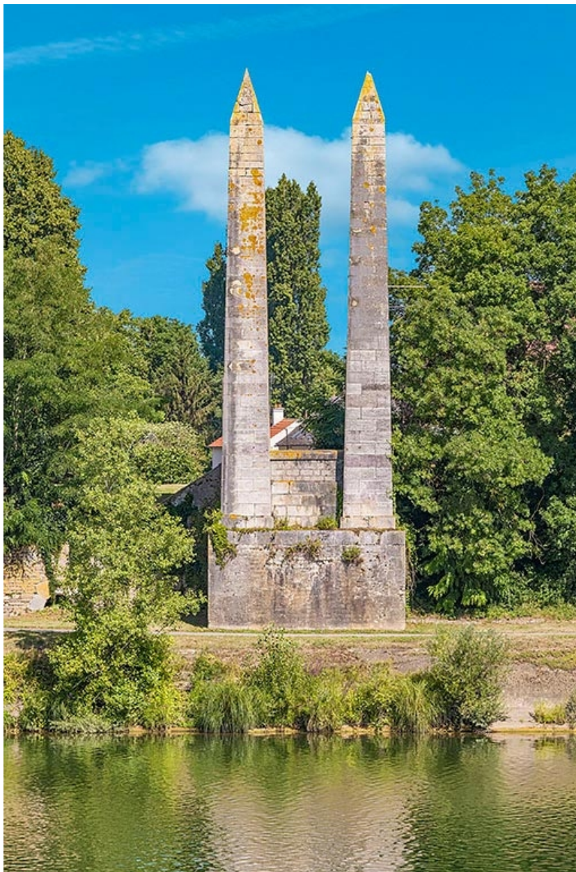
Les pylônes de l'ancien pont suspendu de Chauvort (71).
