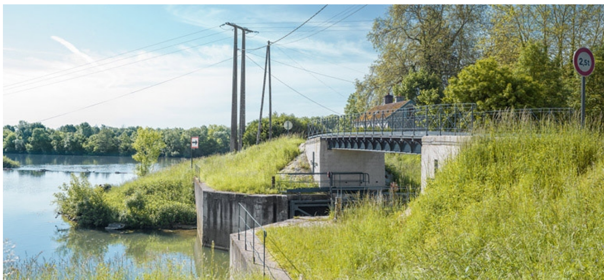
Le pont sur la porte de garde d'Heuilley (21).
