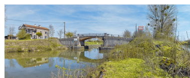
Le pont sur le site d'écluse de Saint-Jean-de-Losne (21). Phot. Thierry Kuntz IVR26_20162101438NUC4A
