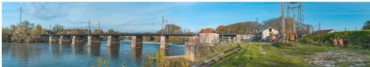
Le pont ferroviaire d'Auxonne (21).
