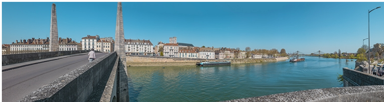
Le pont Saint-Laurent de Chalon-sur-Saône (71).
