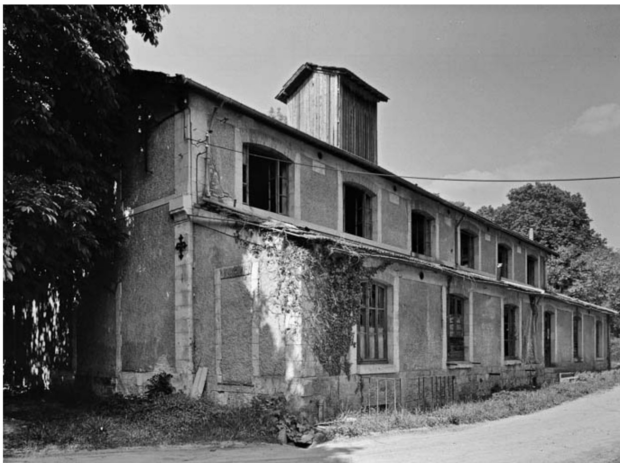
État en 1984, vue depuis le sud-ouest.
