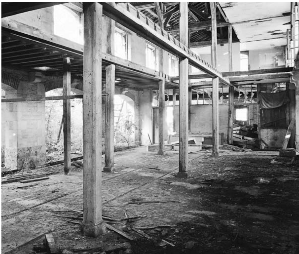
État en 1984, vue intérieure.
