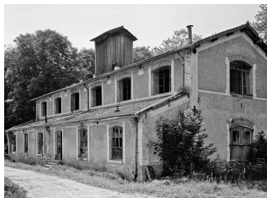
État en 1984, vue depuis le sud-est. Phot. Jean-Luc Duthu IVR26_19845800040V
