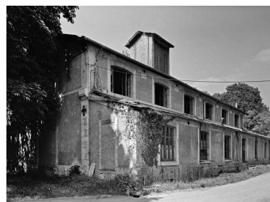
État en 1984, vue depuis le sud-ouest. Phot. Jean-Luc Duthu IVR26_19845800041V
