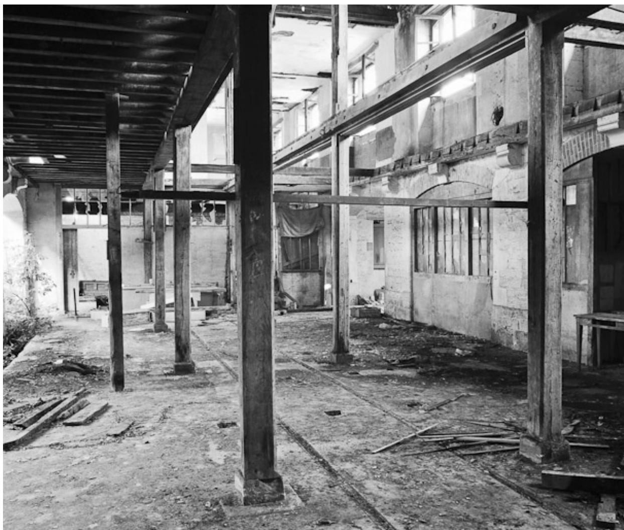
État en 1984, vue intérieure.
