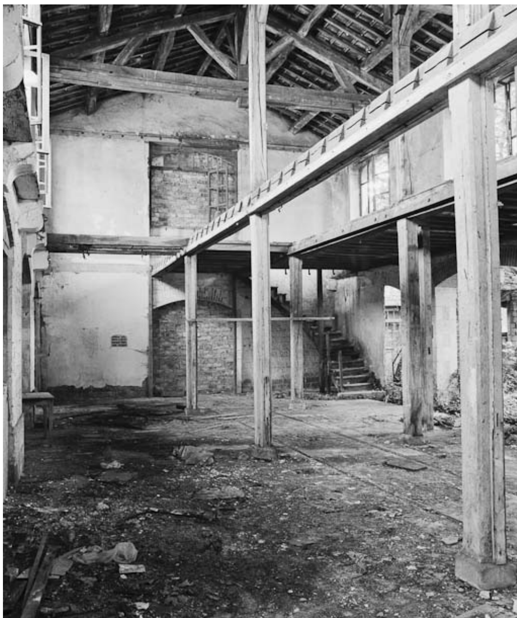
État en 1984, vue intérieure.
