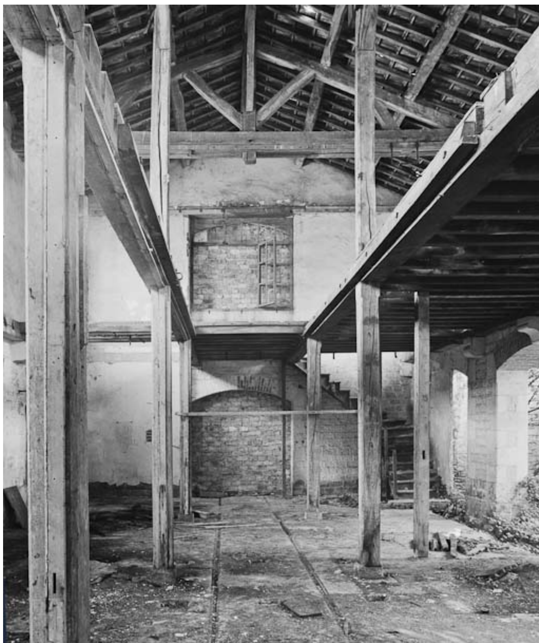
État en 1984, vue intérieure.
