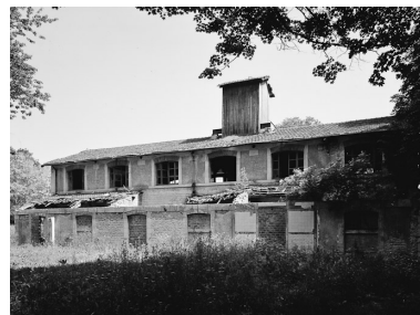
État en 1984, vue depuis le nord. Phot. Jean-Luc Duthu IVR26_19845800043V
