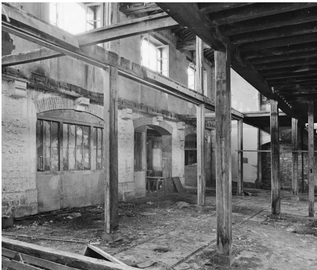
État en 1984, vue intérieure.
