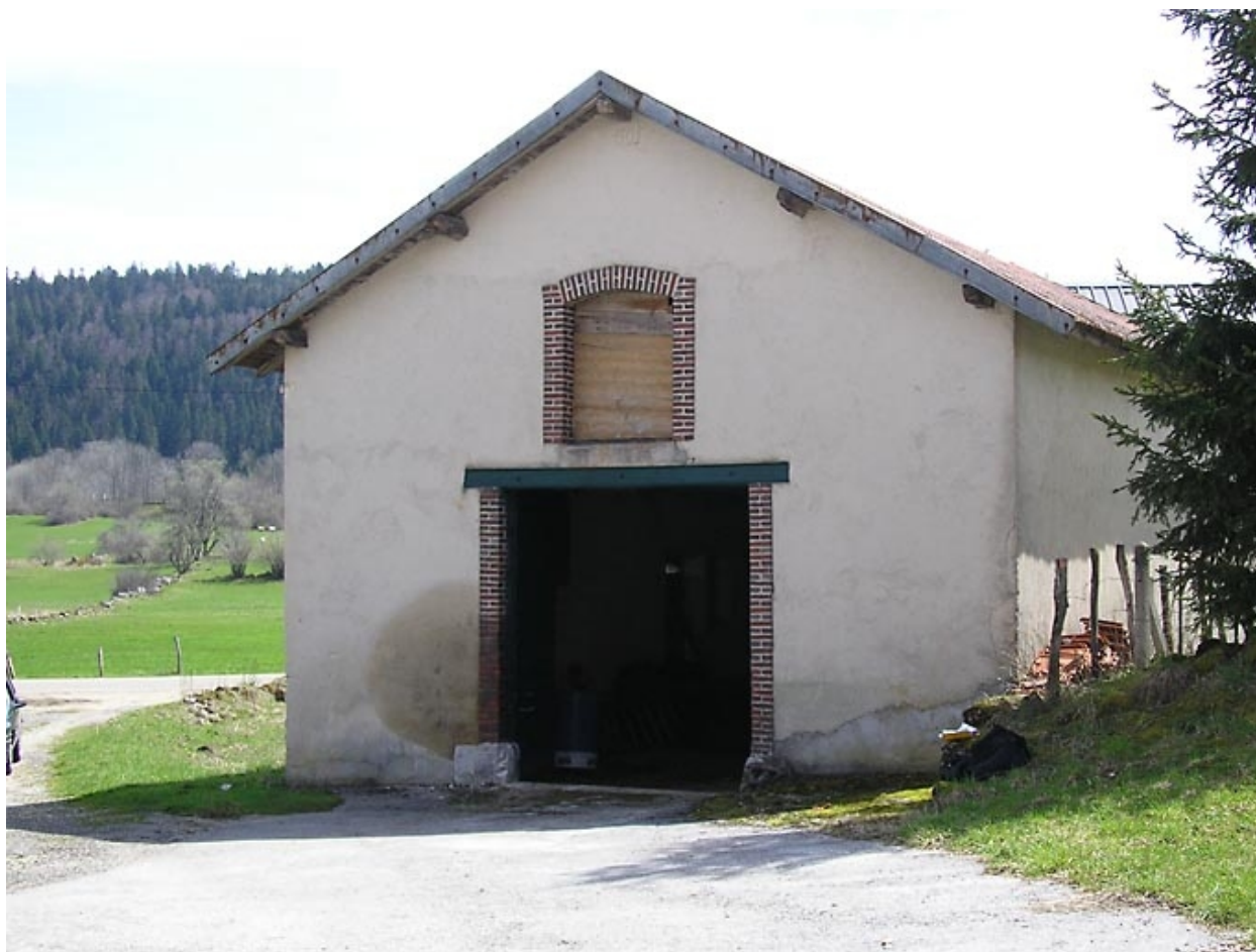
Vue de l'entrée du hangar agricole.
