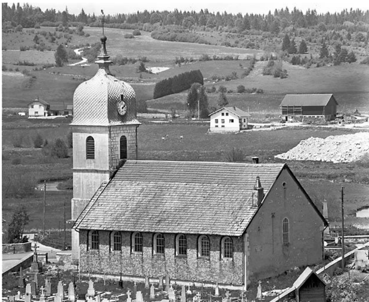
Façades postérieure et latérale droite.
