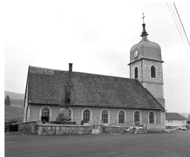
Façade latérale gauche. Phot. Yves Sancey IVR43_19782500436X
