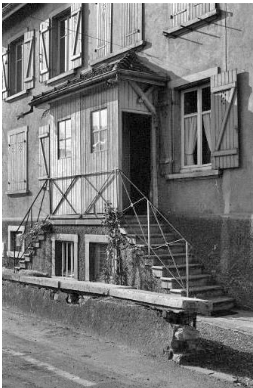
Détail de l'élévation antérieure.
