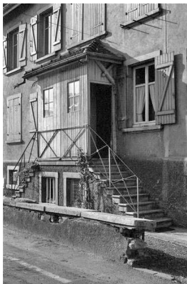
Détail de l'élévation antérieure. Phot. Bernard Lardière IVR43_19832500297Z
