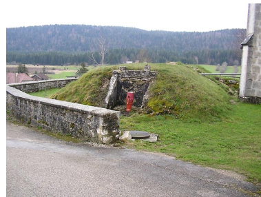
Vue de la citerne. Phot. Marie-Pierre Reynet IVR43_20083900146NUC1A
