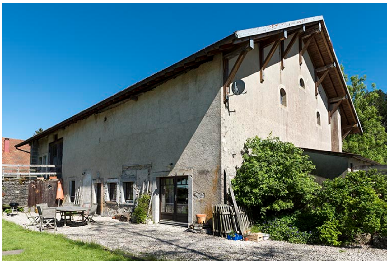
Façades postérieure et latérale gauche.
