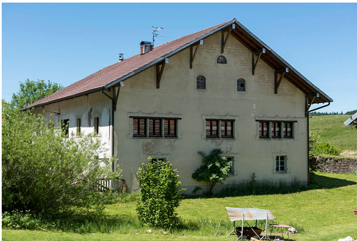
Façade latérale droite, de trois quarts gauche.
