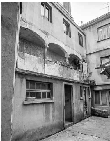
Galerie sur cour intérieure. Phot. Yves Sancey IVR43_19802500208X
