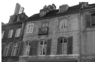
Façade antérieure : les étages. IVR43_19682500199Z
