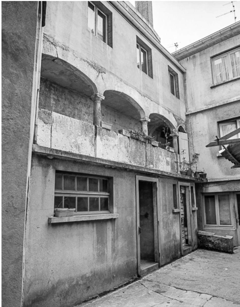
Galerie sur cour intérieure.
