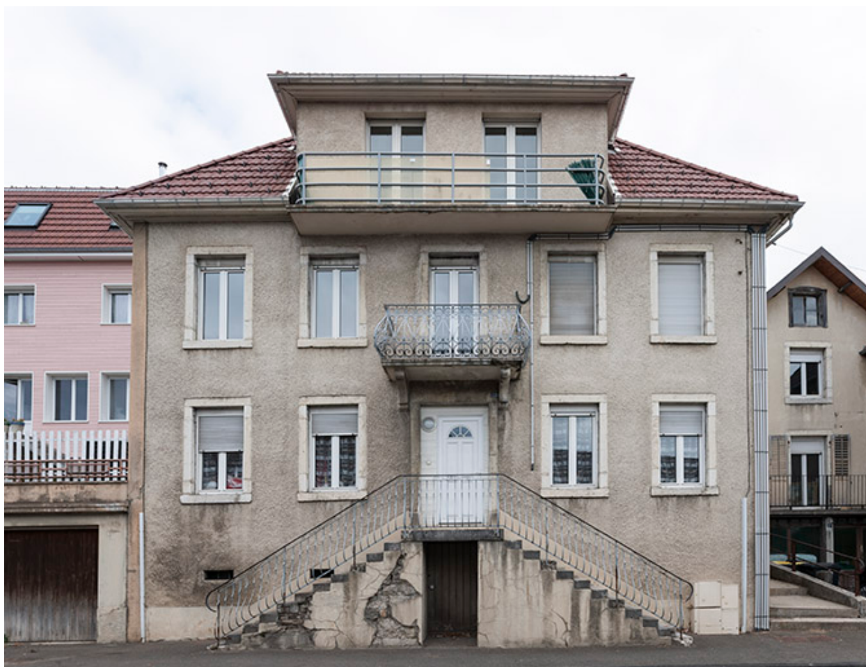
Maison : façade antérieure.
