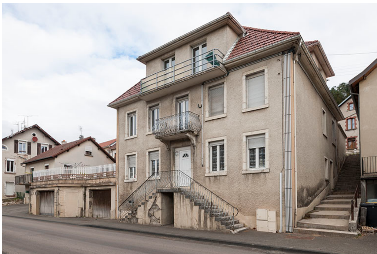
Maison : façades antérieure et latérale droite.
