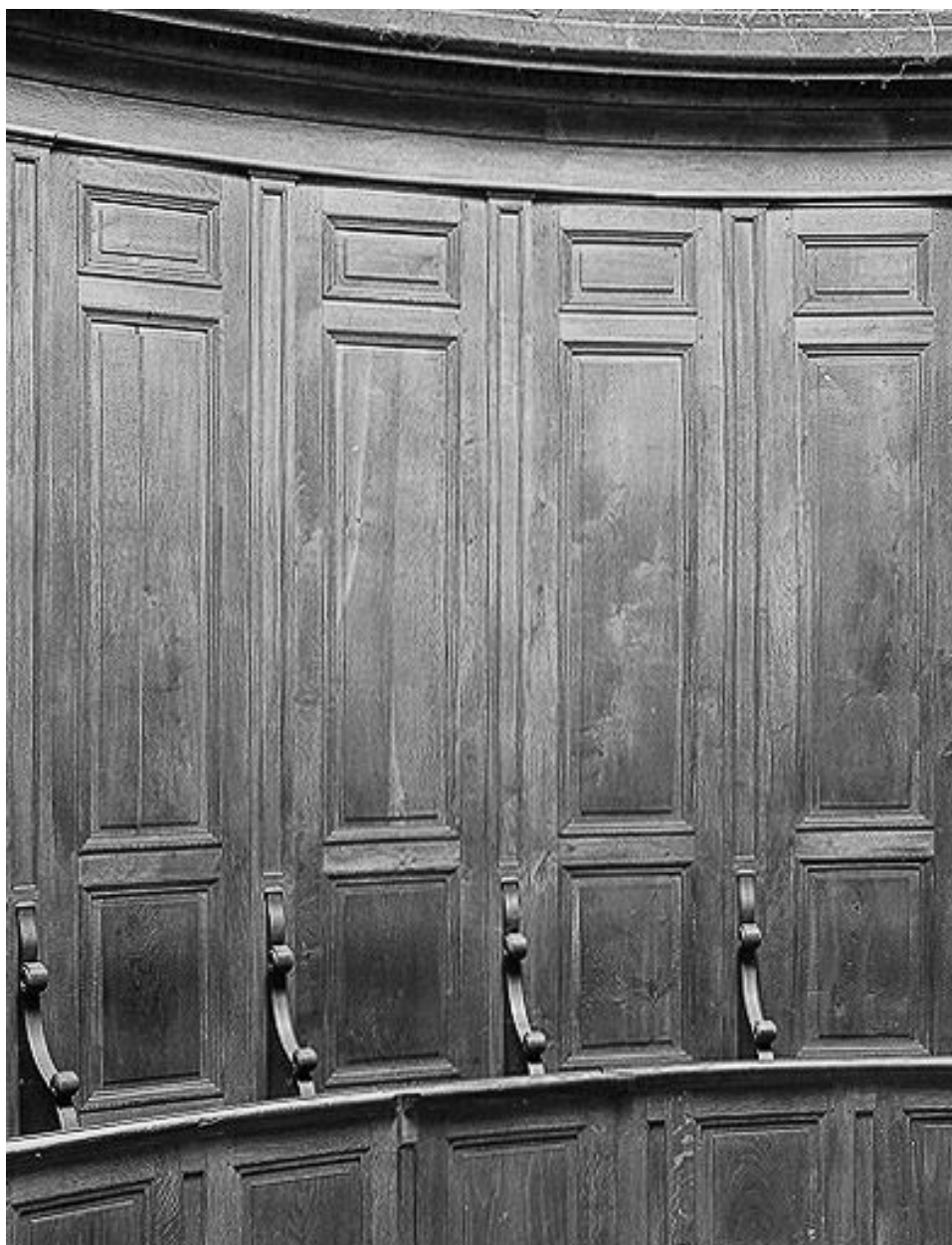
Intérieur : lambris et stalles de l'abside, détail.
