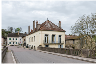
Pontailier-sur-Saône, 62-64 rue du 8 Mai 1945 : le Tivoli. Phot. Pierre-Marie Barbe-Richaud IVR26_20242100189NUC4A
