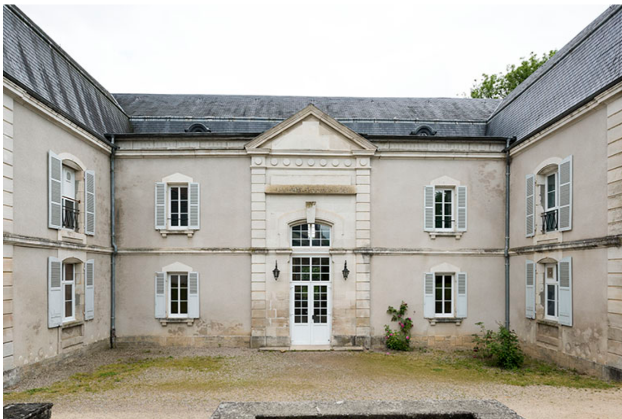
Vue sur la travée centrale
