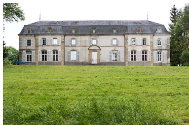
Vue générale. Phot. Sonia Dourlot IVR43_20167000618NUC4A
