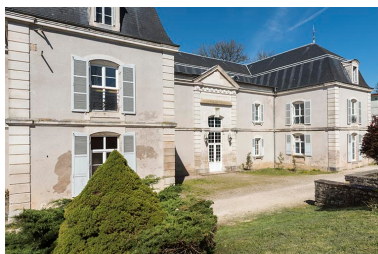
Les ailes symétriques et la travée principale. Phot. Sonia Dourlot IVR43_20167000612NUC4A
