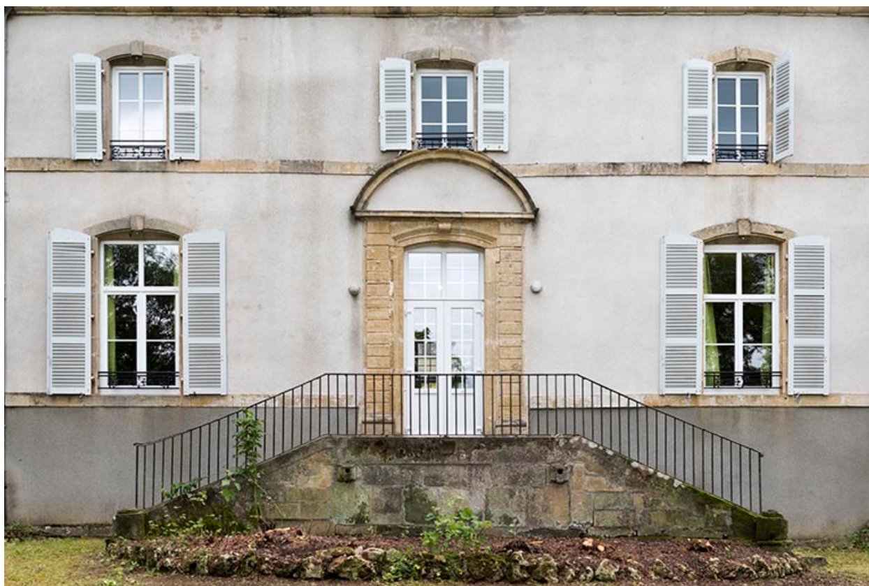
Les travées centrales.
