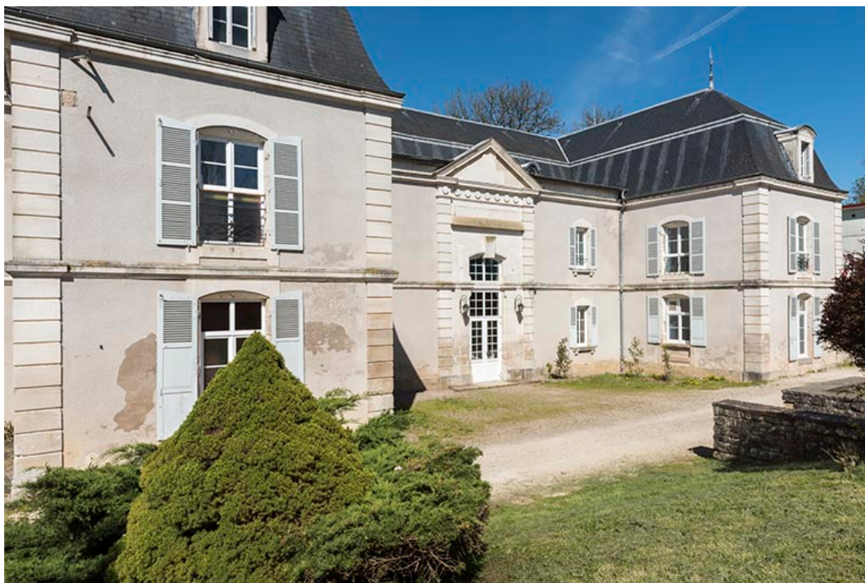
Les ailes symétriques et la travée principale.
