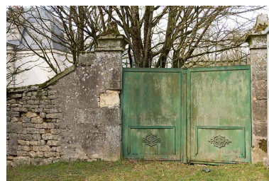
Ancienne entrée. Phot. Sonia Dourlot IVR43_20167000627NUC4A
