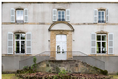
Les travées centrales. Phot. Sonia Dourlot IVR43_20167000617NUC4A
