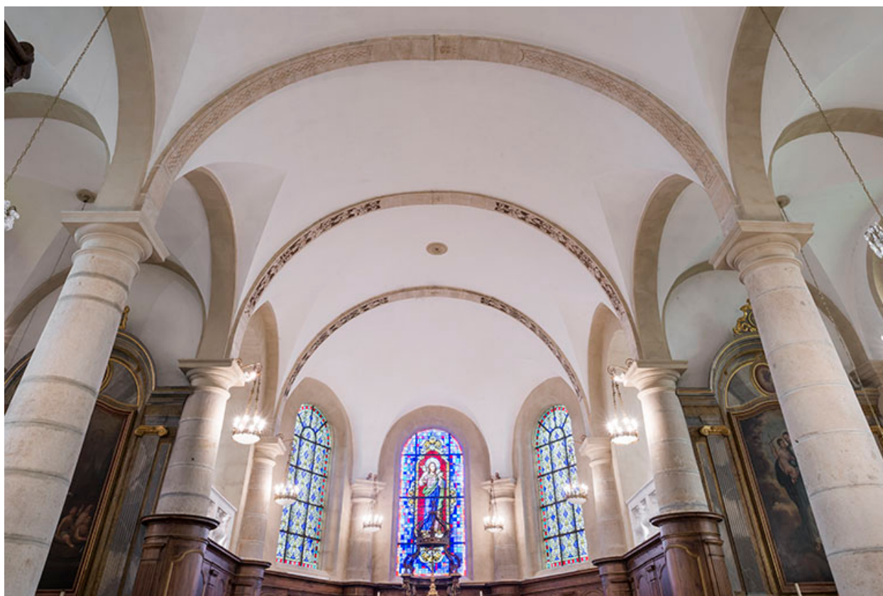
La voûte en berceau.
